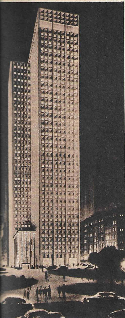
Mit vorfabrizierten Aluminiumplatten wurde ein Bürowolkenkratzer in Pittsburgh verkleidet. Die Arbeiter benötigten zu diesem Riesengebäude nur eine Woche.
