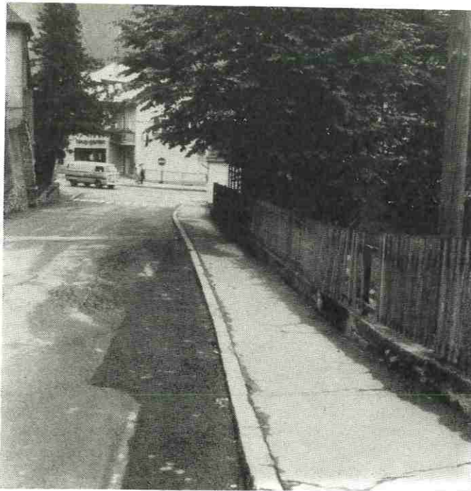
Die Absenkung in der Innstraße
