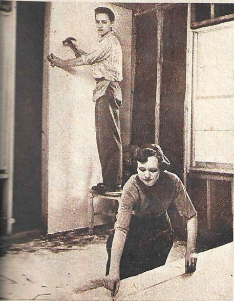
Ein neues Kinderzimmer entsteht durch Anziehen neuer Wände in einem Abstellraum. Die Bauplatten, aus denen man selber Zwischenwände aufführen kann, werden von zahlreichen Firmen auf den Markt gebracht.
