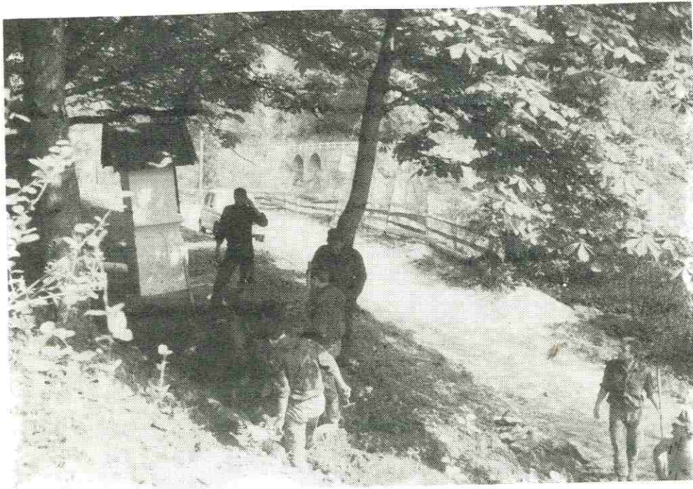
Das „Kapellele“ im Gramlach wurde trocken gelegt.
