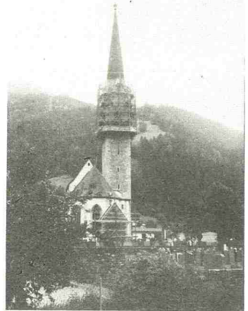
Das Turmgerüst der Stadtpfarrkirche
