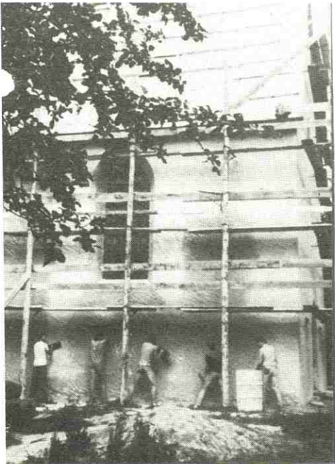
Pfadfinder bei der Behandlung des Außenputzes der Burschlkirche
