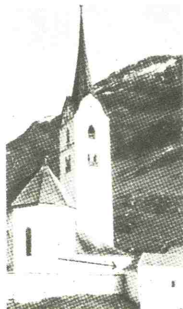
Das alte „Kassa-Haisli“ an der Friedhofsmauer (bis 1954)
