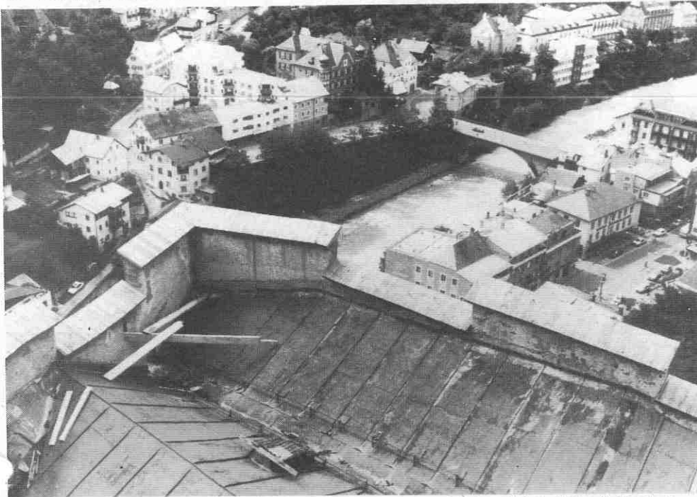
Die Mauerkrone wurde mit Lärchenbrettern gedeckt; das Dach wird demnächst mit Kupferblech eingedeckt.
