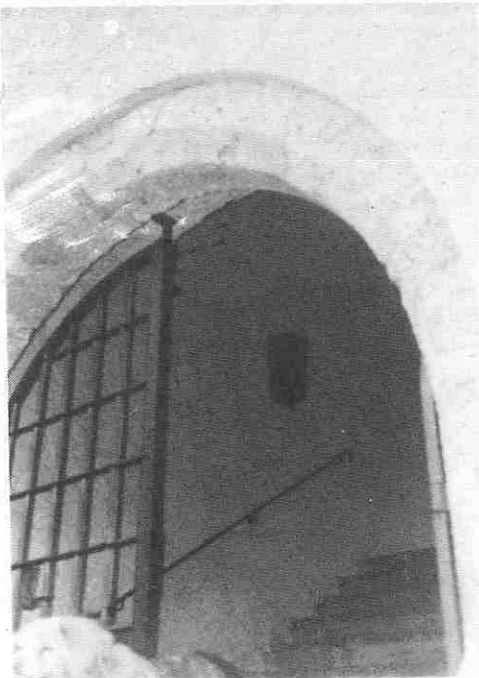
Der Verputz von Hallenaufgang und -eingang ist nicht gut gelungen (bitte äußerster Vorsicht bei der Fassade!) Fotos Perktold
