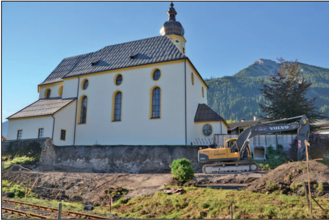
Sanierung der eingestürzten Friedhofsmauer
