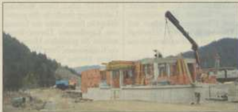
NOCH BAUSTELLE – bald Sicherheits-Checkpoint.
