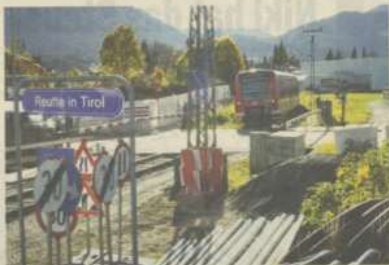
Die Signale für die Außerfernbahn stehen dauerhaft auf Grün. Foto: Archiv
