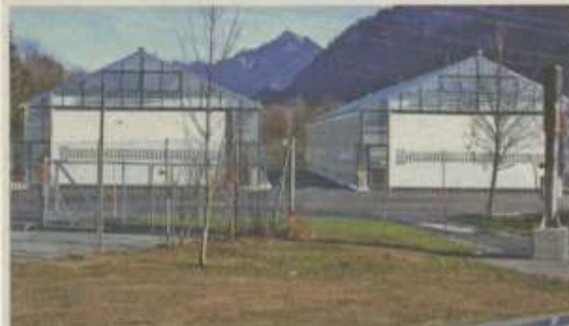
Ein einfaches und zugleich optimales Prinzip: In zwei großen Glashäusern wird der Klärschlamm getrocknet. Das hilft Geld zu sparen.
