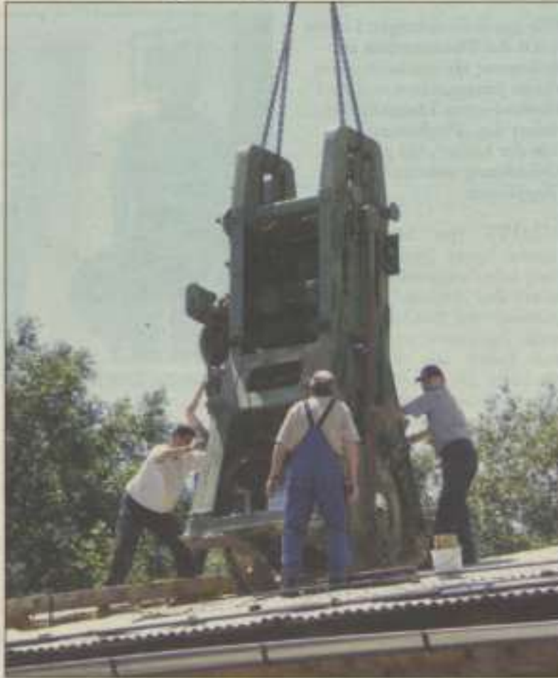
DAS „HERZSTÜCK“ des alten Sägewerkes wird entfernt.
