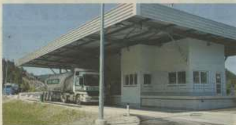
Unter einer 600 m 2 großen Dachkonstruktion können LKWs, Busse, PKWs und Einspurige überprüft werden.
