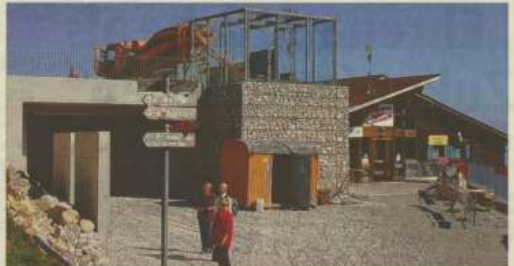
Nicht nur um eine Garage für die Pistenraupe ist die Bergstation der Breitenbergbahn erweitert worden. Das neue Gebäude bietet auch Sanitärräume sowie einen spektakulären Einstieg in den Geo-Pfad Pfronten-Vils. Foto: Gisela Schroeder
