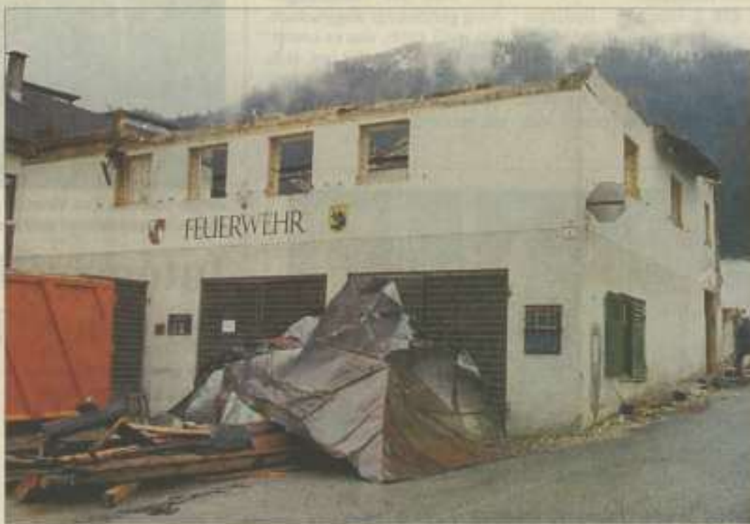
Mit dem Abbruch des alten Feuerwehrhauses wurde bereits begonnen.
