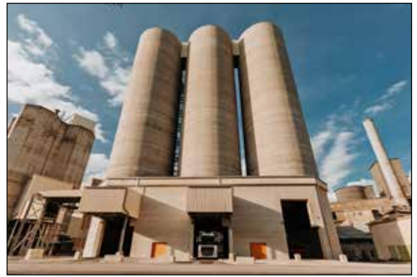
Frontansicht neue Siloverladeanlage
