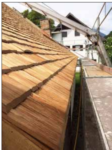
Die Esse macht auch schon Fortschritte
