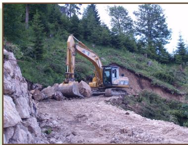
Forstwegebau mit Hydraulikbagger im Bereich Flüsslen hoch
