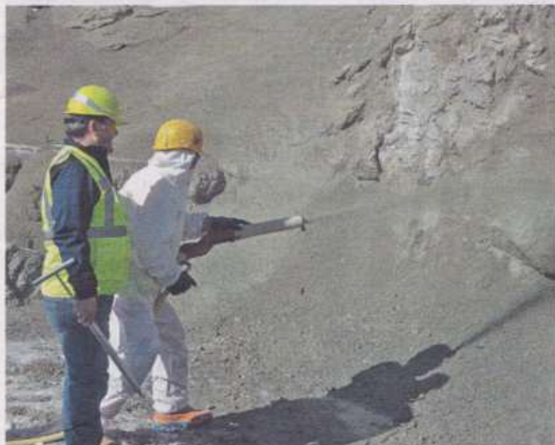
Paul Tschol (TBA Zams) erklärt einem Teilnehmer den praxisgerechten Einsatz bei der Spritzbetonvorführung in Vils.
