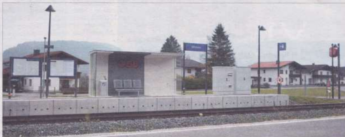
Die Haltestelle und der neue Bahnsteig wurden in Musau auf die andere Gleisseite verlegt und neu errichtet. RS-Fotos: Hohenrainer
