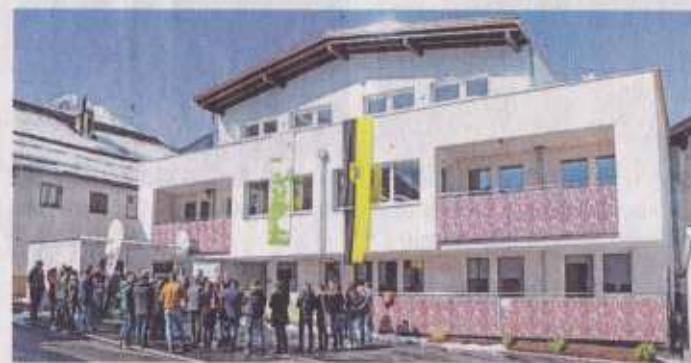
Auf der über Jahre leer stehenden Fläche wurden elf Wohneinheiten nach modernstem Standard errichtet.
