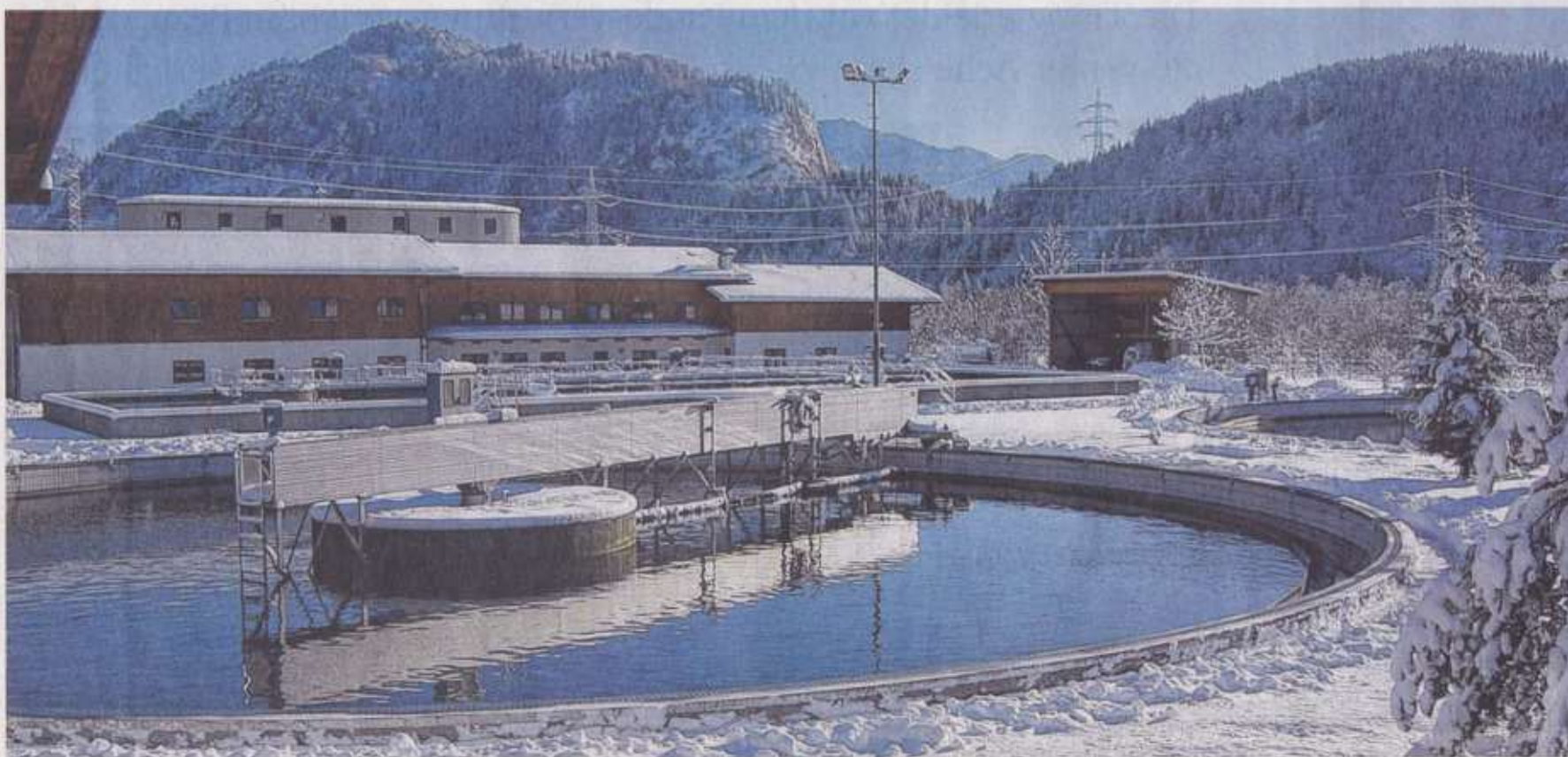
Mehr als fünf Millionen Kubikmeter Abwasser werden jedes Jahr in der Kläranlage in Vils gereinigt.
