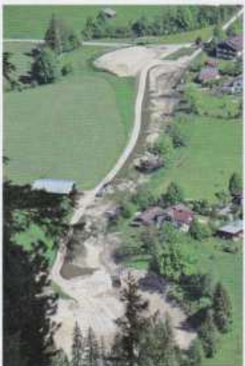
Die Verbauung des Lehbaches ist voll im Gange und soll das Siedlungsgebiet sichern.
