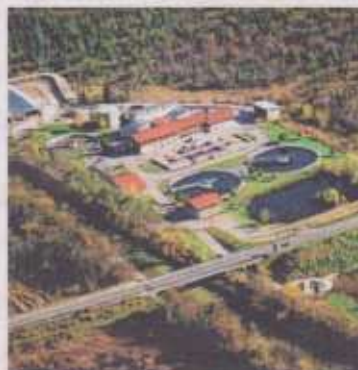
In der Kläranlage werden täglich ca. 10.300 m 3 Abwasser gereinigt. Foto: ARA Vils
