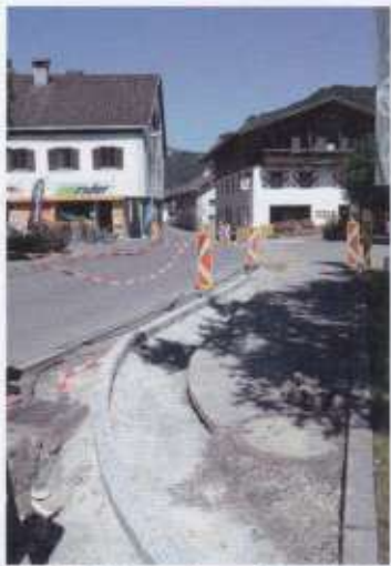
Derzeit gibt es mehrere Baustellen in Vils, unter anderem werden Gehsteige erneuert.
