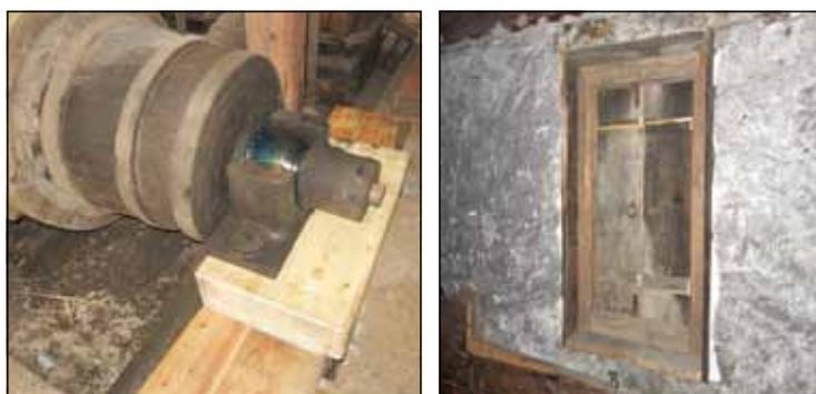
das Lager der Daumenwelle im Inneren der Schmiede gerichtet und ein kleines Fenster im oberen Stock der Schmiede eingebaut.
