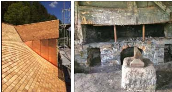
... das Dach komplett ersetzt, die Esse abgestützt,
