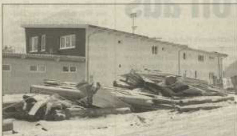
Abgedeckte Dächer, wie hier in Vils, gab es im Bezirk mehrere.
