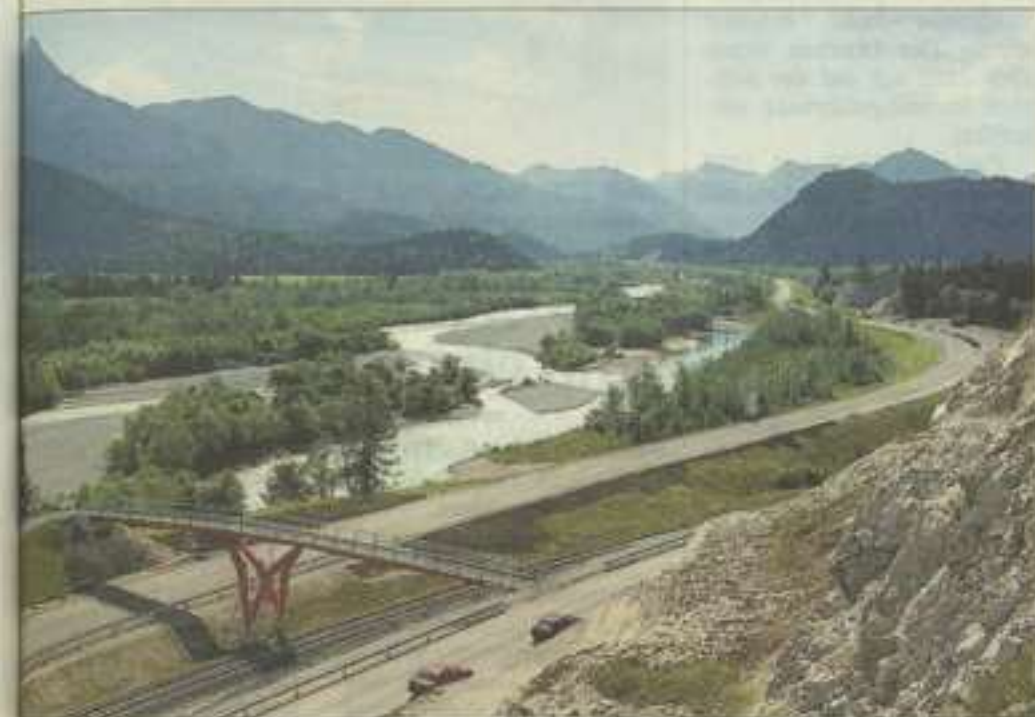
NEUE BUNDESSTRASSE verläuft von der Ulrichsbrücke bis zur Umfahrung Reutte/Nord am Lech. Im Vordergrund spannt sich eine Radlerbrücke über die Umfahrung. Foto: Huber
