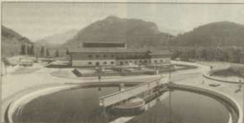
Die Anlage ist für 70.000 Einwohnerwerte ausgelegt und ist noch erweiterbar.
