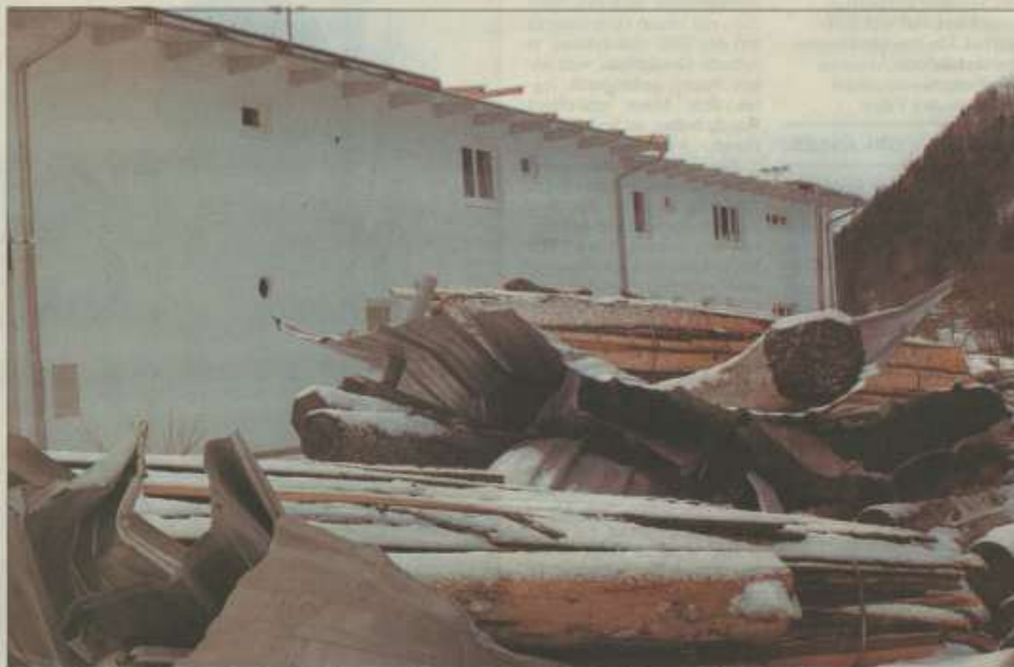
DER STURM wirbelte einen Großteil des 390 qm großen Blechdaches des Vilsener Fußballclubheimes durch die Luft.
