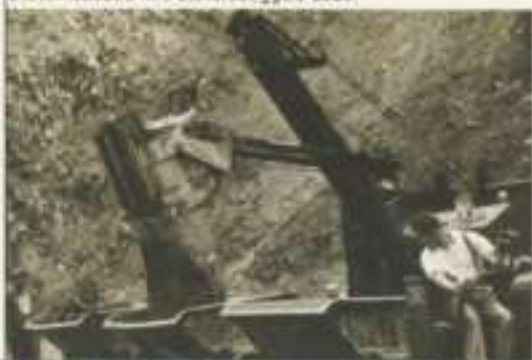
Gesteinsabbau mit Elektrobagger, 1939
