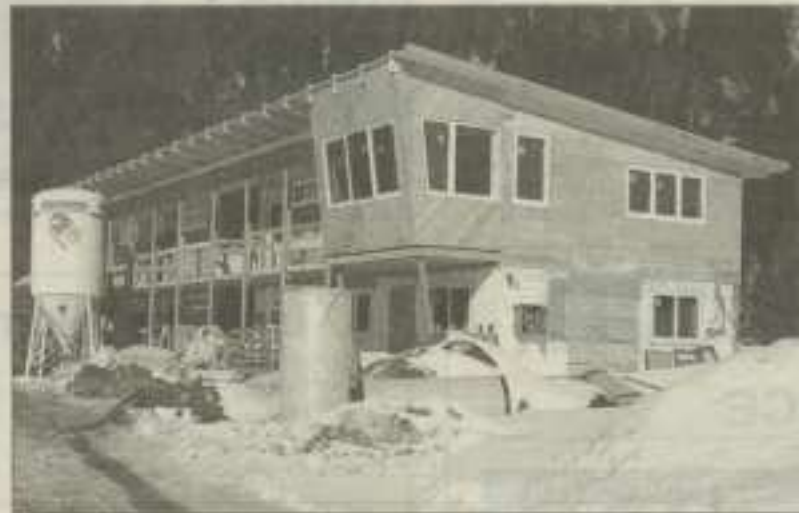
Kicker absolvierten das etwas andere Konditionstraining am Bau. Foto: Sorg
