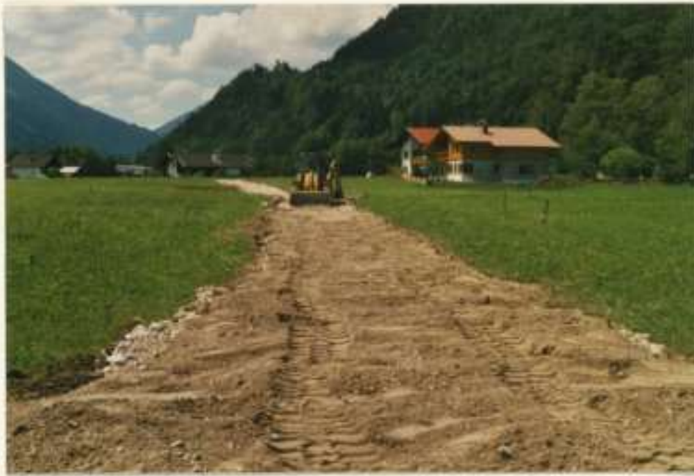
Erschließung des neuen Wohngebietes Alatseeweg – Hoheneggweg
