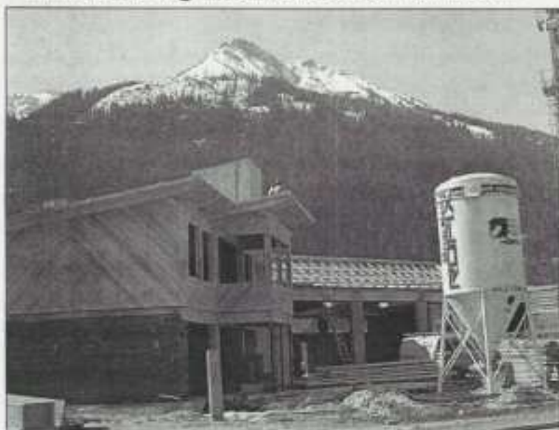
Die Zimmerei Josef Petz stellte kürzlich den Dachstuhl für die Feuerwehrhalle auf. Die Arbeiten gehen zügig voran.
