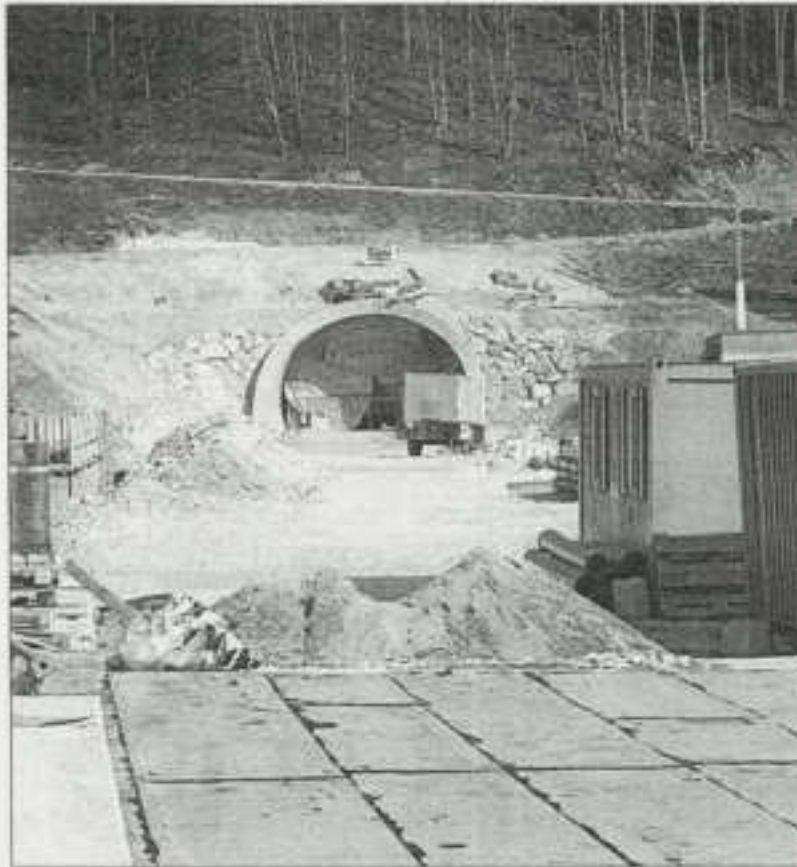
Lange kann es nicht mehr dauern, dann wird der Grenztunnel dem öffentlichen Verkehr übergeben.
