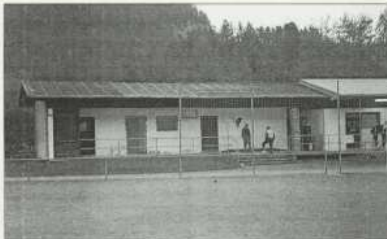
Das alte Clubhaus war einfach nicht mehr zeitgemäß. Mit der Hilfe vieler Firmen und hundert freiwilliger Helfern wurde es abgerissen...
