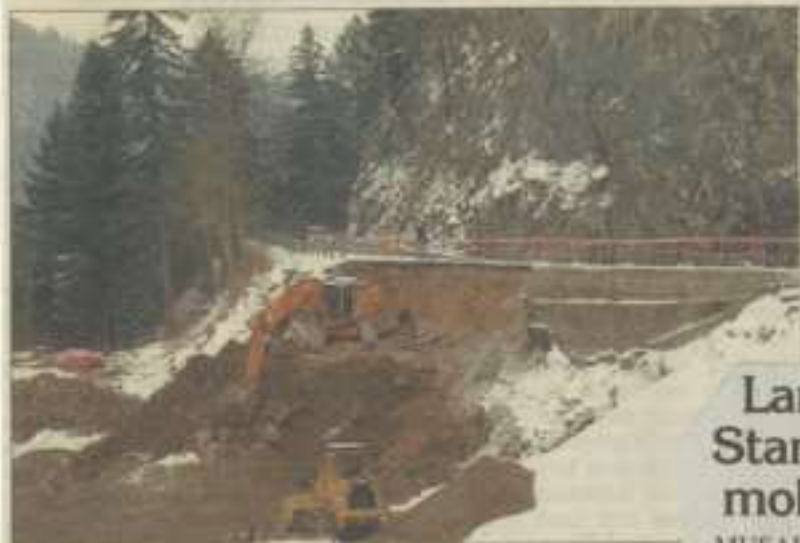
Die Arbeiten an der Weißhausstraße sind bereits voll ange laufen.
