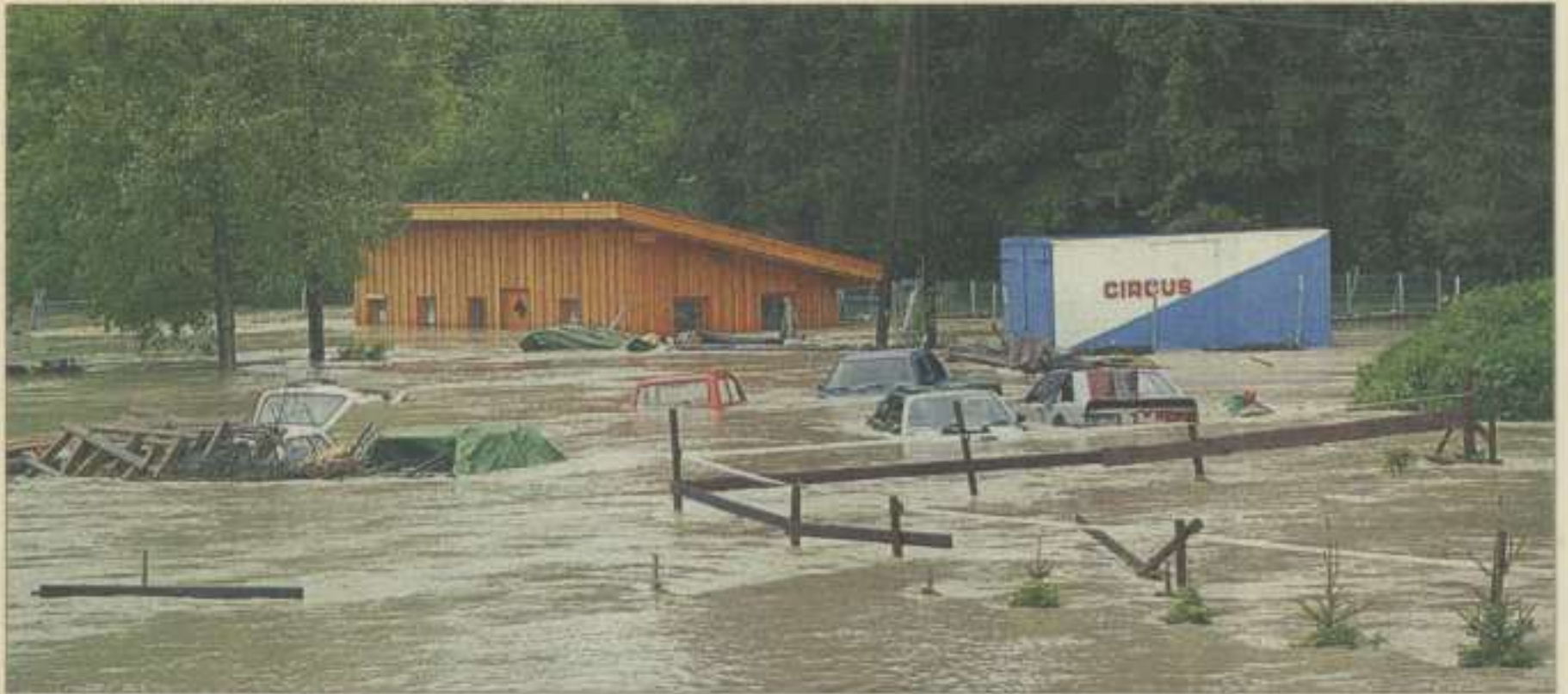
DAS NEUERBAUTE TIERHEIM in der Reuttener Löß war nicht mehr zu retten, die „Insassen“ konnten aber rechtzeitig evakuiert werden.
