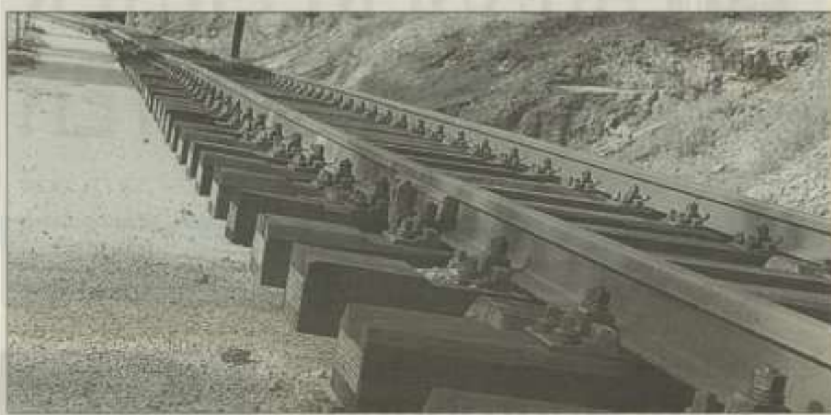
Die Sanierung der „Hängebrücke“ steht vor dem Abschluß.
