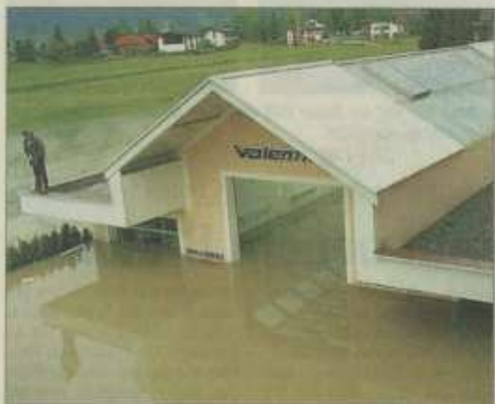
MILLIONENSCHADEN für den Betrieb der Malerei Valentin in Reutte. Das Gebäude wurde bis unter die Decke geflutet. Foto:
