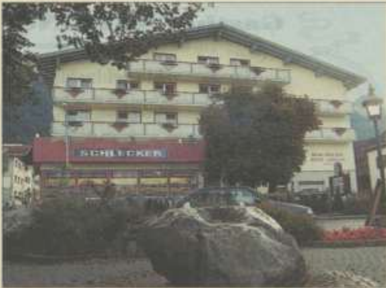
Der Grüne Baum wurde von Grund auf erneuert.
