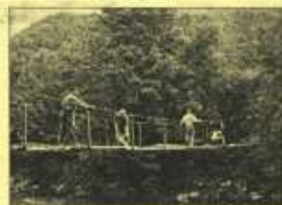
In dem Grotz – in dem Talraum unter St. Anna Brücke wurde ein ein- und zweifelhäufiger Arbeit wieder hergestellt und in höchsten Zustand gebracht.
