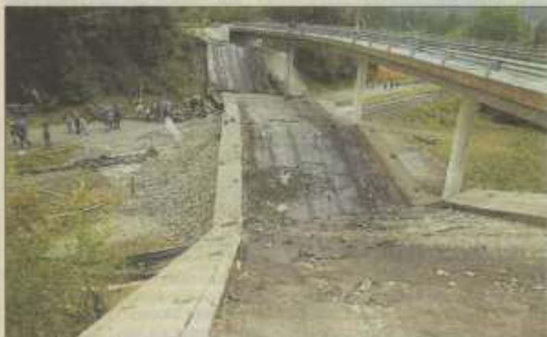
Eine Hälfte der Umfahrungsbrücke wurde am Freitag gesprengt.
