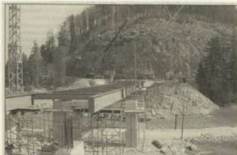
REUTTE. Kürzlich wurde die nächste Baustufe an der Ulrichsbrücke abgeschlossen. Die Stahlträger wurden montiert. Das Gesamtgewicht der Träger beträgt 100 Tonnen. Insgesamt werden 1000 Kubikmeter Beton bei der Ulrichsbrücke verbaut. Bis zur Fertigstellung werden 15 Millionen Schilling verbaut.
