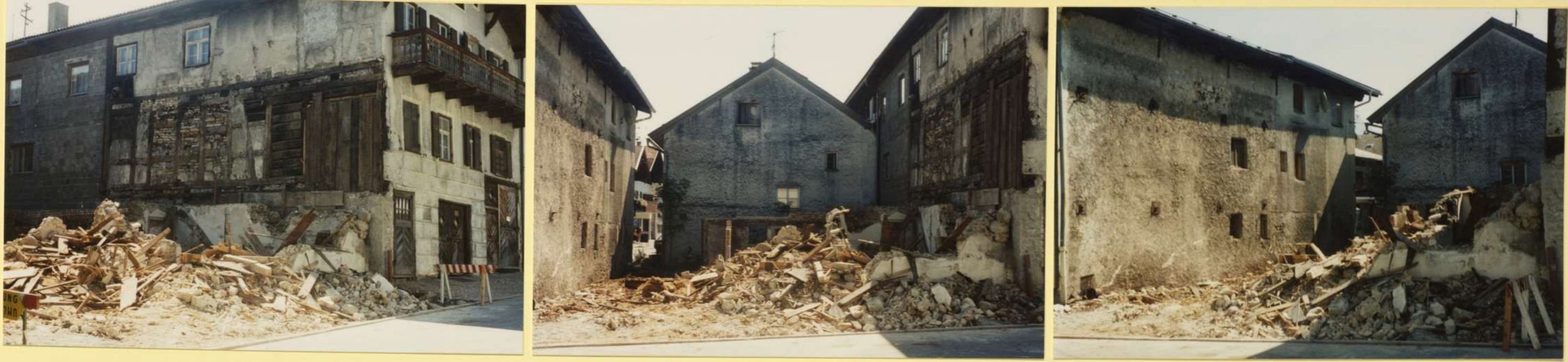
17.08.1995 - das Haus Stadtgasse 3 wird abgerissen - Neubaü dann 1996
