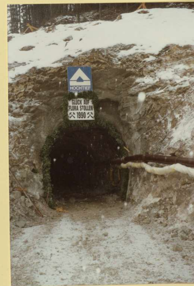
Flora-Stollen bei der Umfahrung Reutte in Pflach
