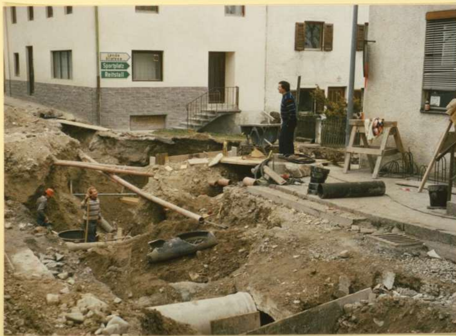
Anfang November 1987, die Kanalarbeiten VILS-Süd schreiten zügig voran.
