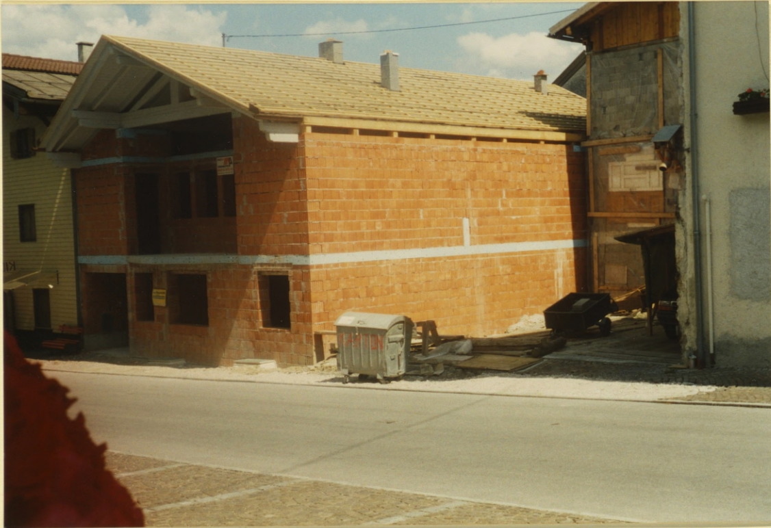
26.07.1996 der Rohbau des Hauses Stadtgas- se 3 von Stebele Agathe ist bereits fertiggestellt
