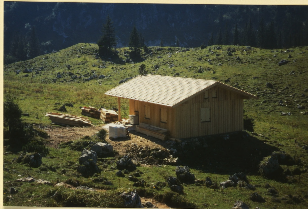
Baubeginn neue Sebenalpe
