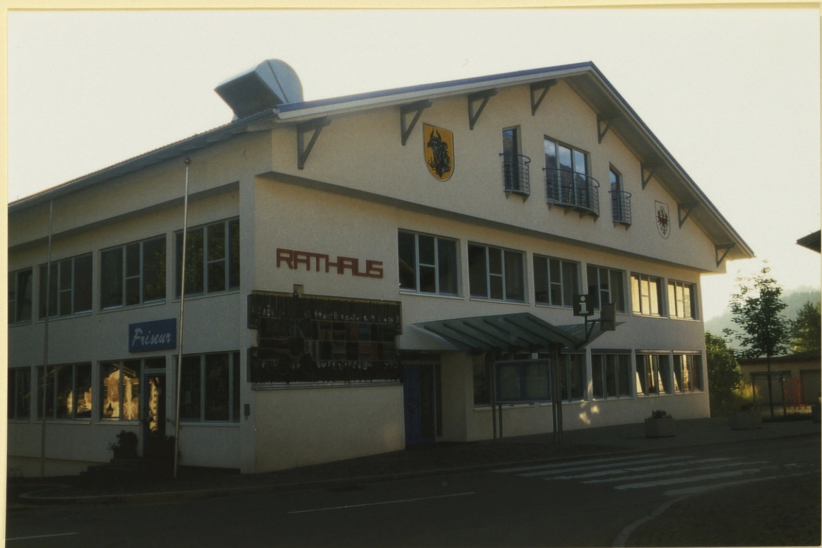
25. Juni 1997 Fertigstellung Renovierung Gemeindehaus
