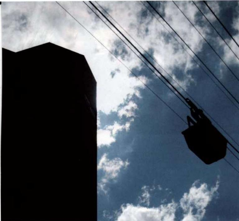
Per Seilbahn wird das Rohmaterial vom Kalk- und Mergelbergbau Vils-Fall angeliefert und in entsprechenden Silos gelagert.
