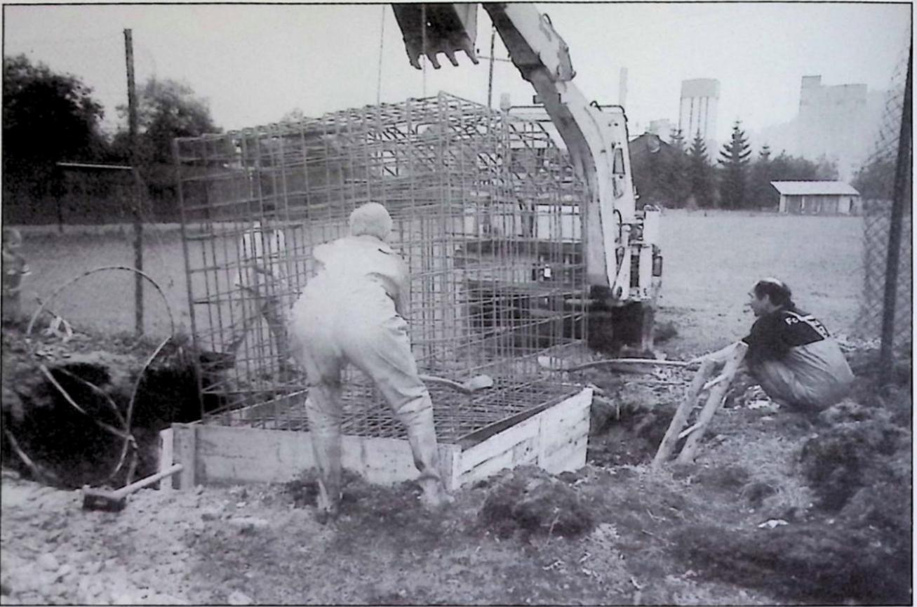
Diese Masten fallen nie mehr um. Dafür sorgt schon der überdimensionale Eisenkorb.
