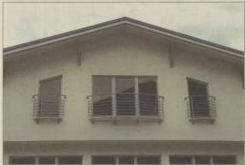
Im Zuge der Dachsanierung hob man auch den Giebel an und baute neue Fenster ein. Dadurch konnten mit einem relativ geringen Aufwand zusätzliche Räume im Dachraum gewonnen werden.
