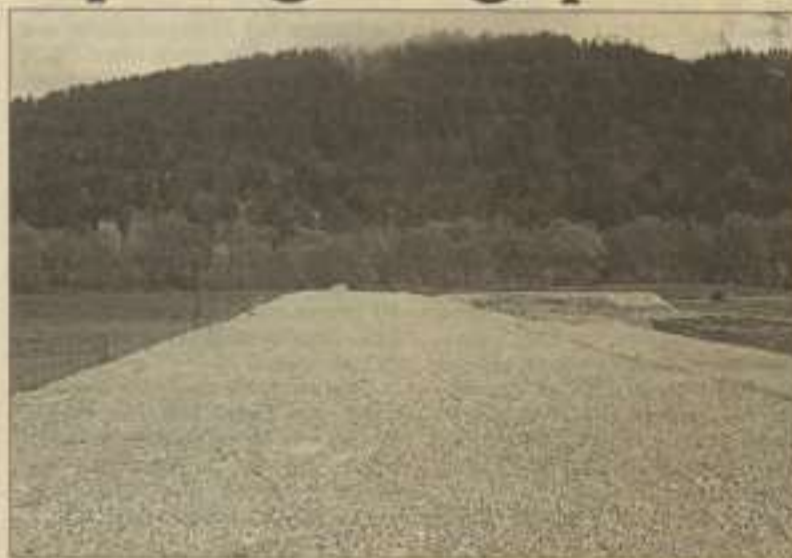
Der Straßendamm endet am Vilsufer bei der Kläranlage. Jenseits des Flusses muß ein Biotop mit einer Brücke überbaut werden. Foto: Huber
