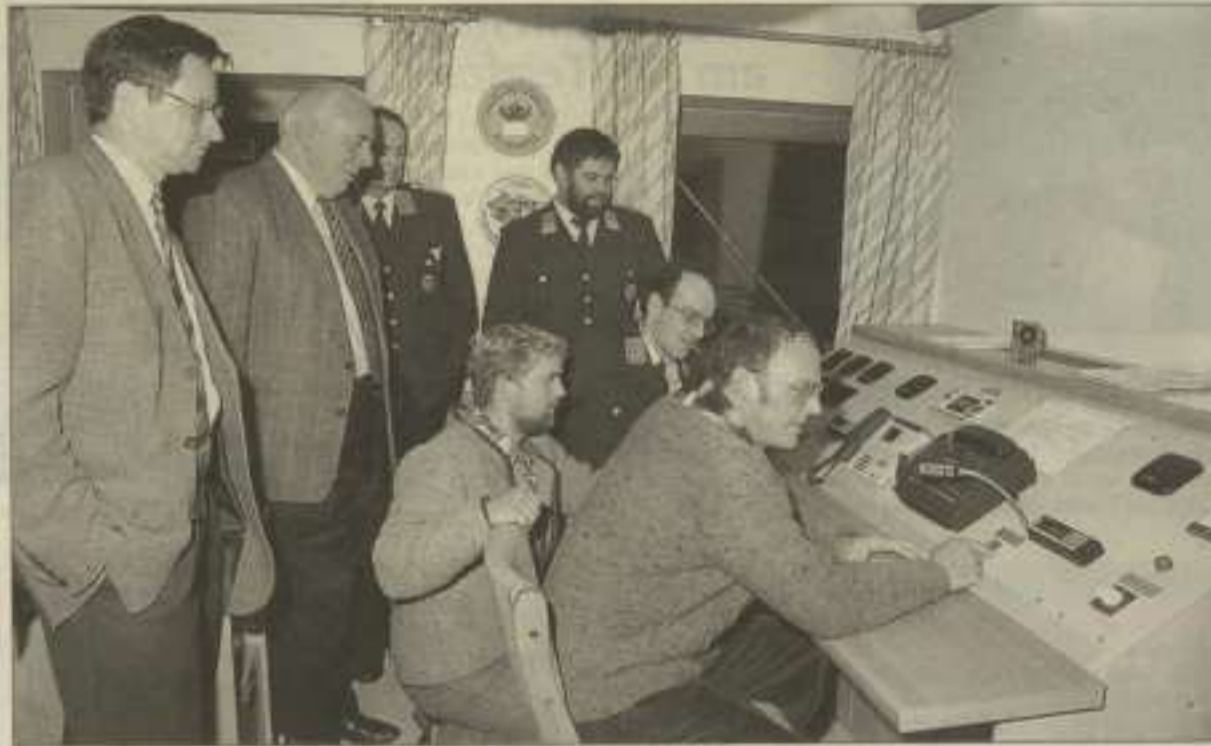
Bei der Inbetriebnahme der funkeingeleiteten Funkstation: die Führung der Feuerwehr und Bergrettung, der Anlagen-Tüftler, die Gemeindeführung und Vertreter der Sponsoren. Foto Huber
