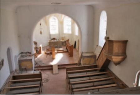
Nach dem Entfernen aller durch Feuchtigkeit und Salze beschädigter Putzschichten im Innen- und Außenbereich sowie der mit Zementputz erfolgten Ausbesserungen wurden die Fehlstellen befundgerecht mit Kalkputz ergänzt. Der Deckputz wurde in seiner Struktur dem Bestand angepasst. Diese Arbeiten nahmen ca. 4 Monate in Anspruch. Anschließend begann die Entfernung aller Verschmutzungen sowie der Algen und Moose. Dies erfolgte so-
