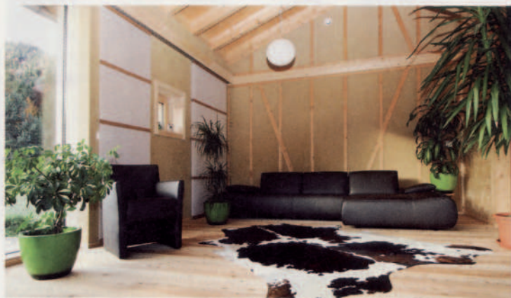
Der Lehmputz wurde nicht geweißelt und strahlt Natürlichkeit und Wärme aus.
