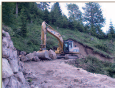
Forstwegebau mit Hydraulikbagger im Bereich Flüsslen hoch
