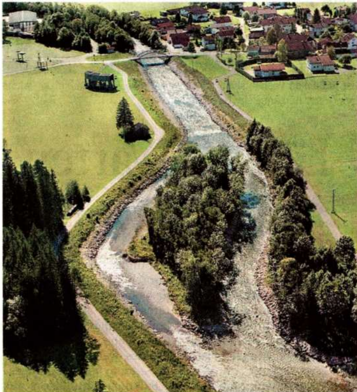
Der Fluss Vils wurde in der Stadt Vils renaturiert und gesichert. Foto: Land Tirol
