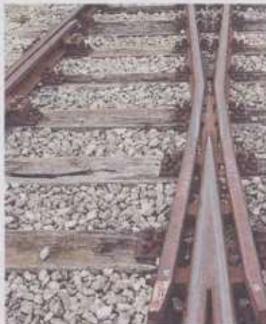
Neben umfangreichen Gleisarbeiten wird bei der Außerfernbahn auch die Elektrifizierung vorangetrieben.
