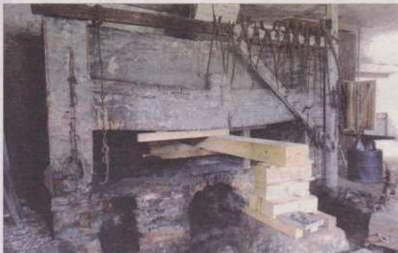
Die alte Esse muss neu unterstützt und der Boden vor ihr von einer rund dreißig Zentimeter dicken Dreckschicht befreit werden. Das alte Werkzeug hängt noch von damals dort.
