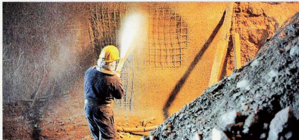
Das Vilsener Unternehmen Schretter & Cie entwickelte einen neuartigen Spritzbeton. Foto: Böhm
