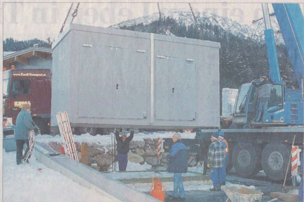
Der Gasverdichter wird beim Autohof Huter in Vils abgeladen.
