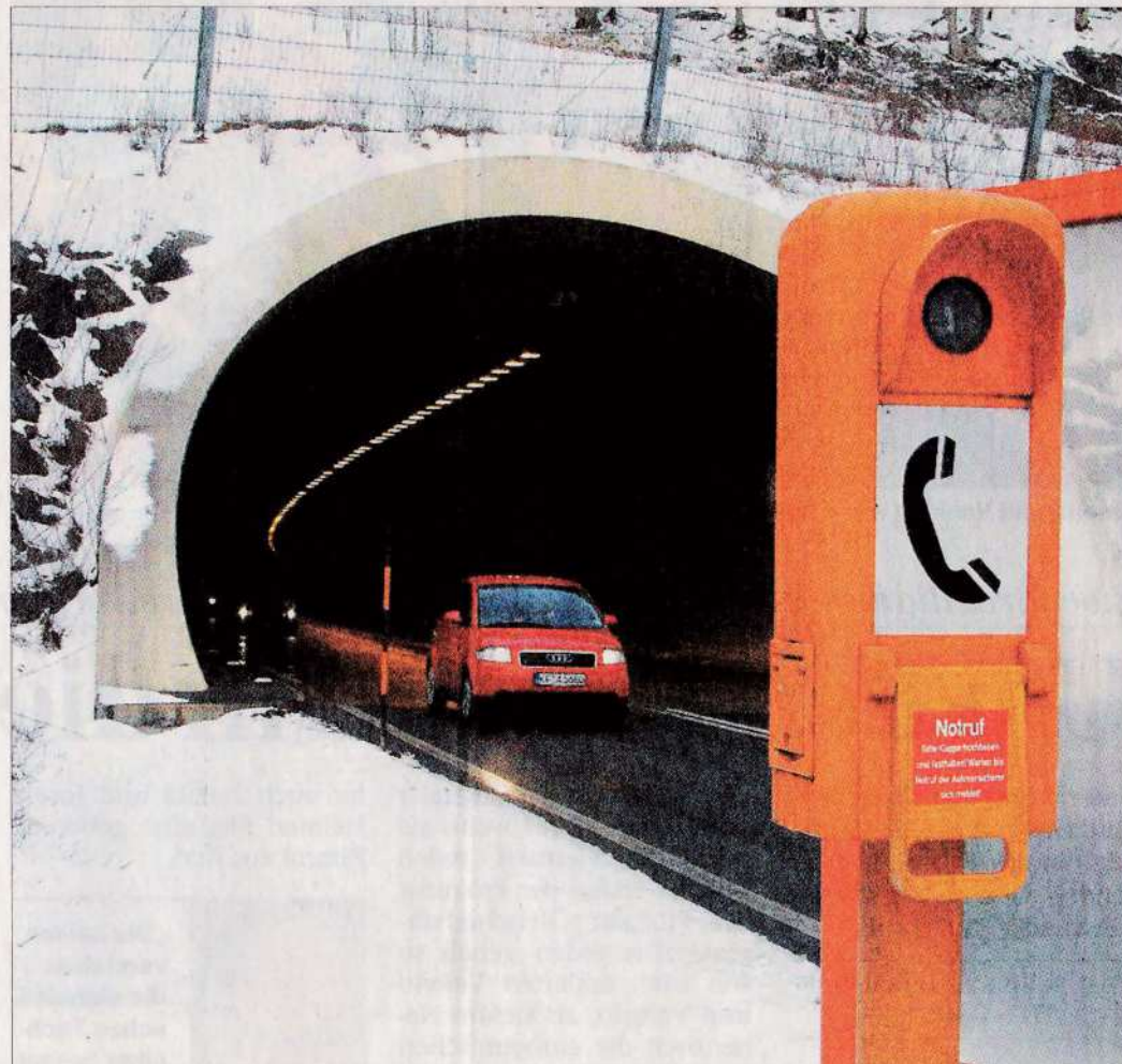
Erhöhte Sicherheit: Der Grenztunnel bekommt einen Flucht- und Rettungsstollen.
