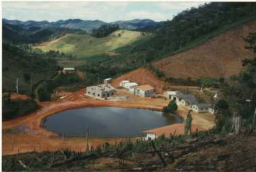
Rohbau der Krankenstation am "Achensee"
