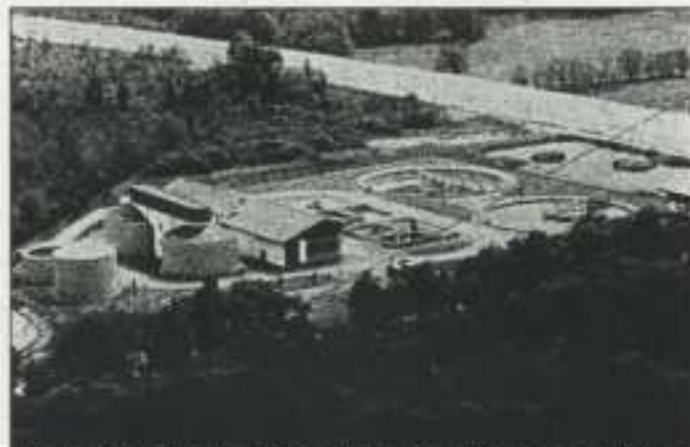
Ihre speziellen Abnehmer für den Klärschlamm haben die Außerferner Abwasserverbände (Bild: Anlage Vils). Foto: Michael
