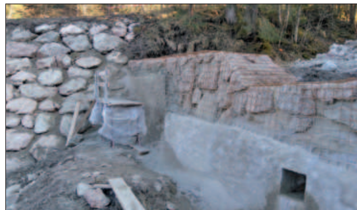
Sperrensanierung mit Spritzbeton
