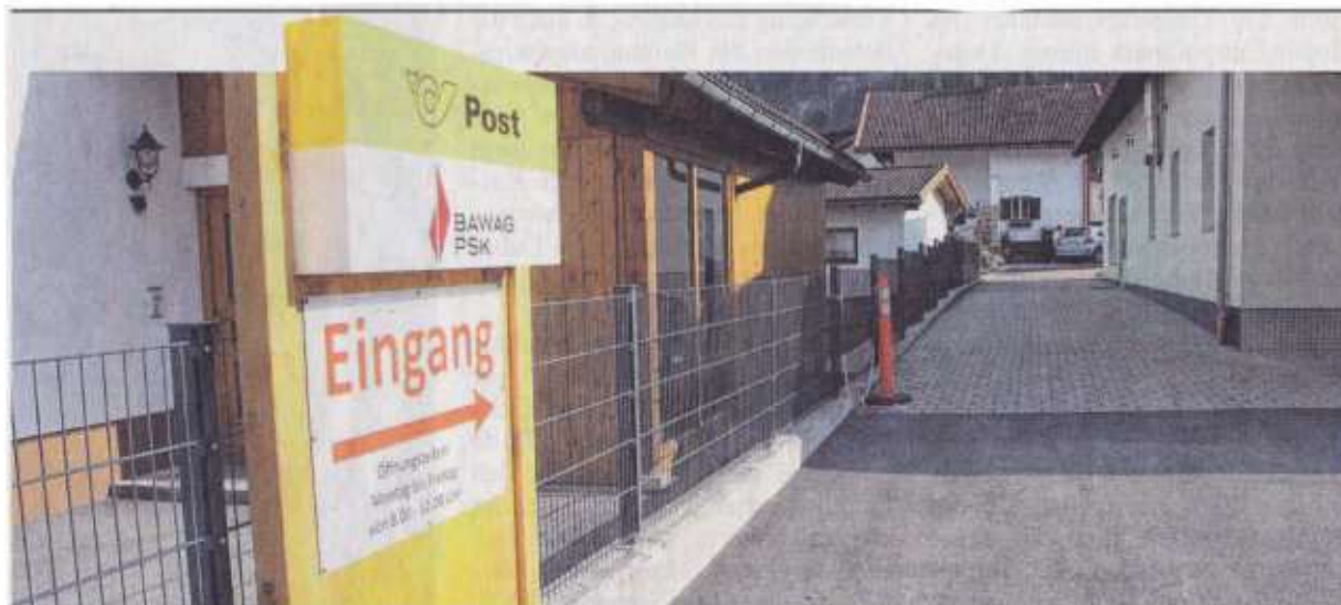
Da geht's lang: Während im vorderen Bereich des Gebäudes an der Bahnhofstraße in Vils das bisherige Café derzeit umgebaut wird, hat im hinteren Bereich die Poststelle weiterhin geöffnet. Foto: Markus Röck
