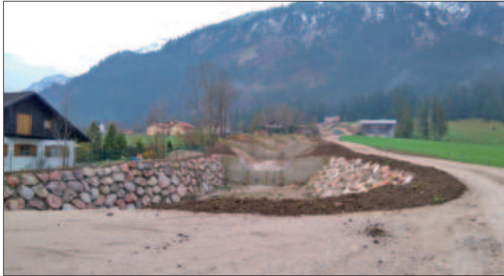
Feingeschiebebecken mit neuer Staffelfung
