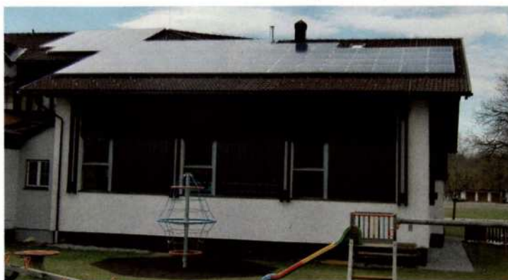
Die Vilsener Firma SET – Stebele Elektro Technik – hat in Pflach auf dem Dach der Volksschule 70 Quadratmeter Solarzellen (20 kWp) und beim Recyclinghof 35 m 2 Solarzellen (10 kWp) installiert.
