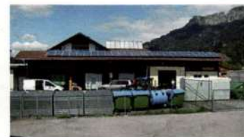
Die Vilsener Firma SET – Stebele Elektro Technik – hat in Pflach auf dem Dach der Volksschule 70 Quadratmeter Solarzellen (20 kWp) und beim Recyclinghof 35 m 2 Solarzellen (10 kWp) installiert.
