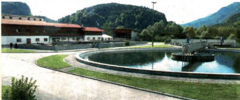
Teilansicht des Vilsener Klärwerks: (v. li.) Betriebsgebäude (im Hintergrund die Faultürme), Lagerhaus für Geräte und Ersatzteile und die beiden hintereinander liegenden Nachklärbecken.
