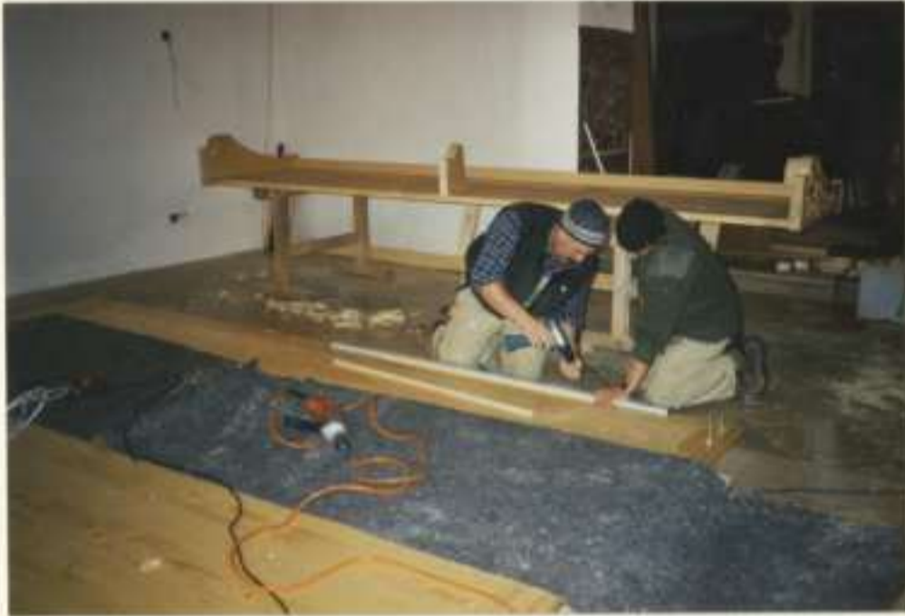
22.11.2002 Die Kirchenbänke werden eingebaut
