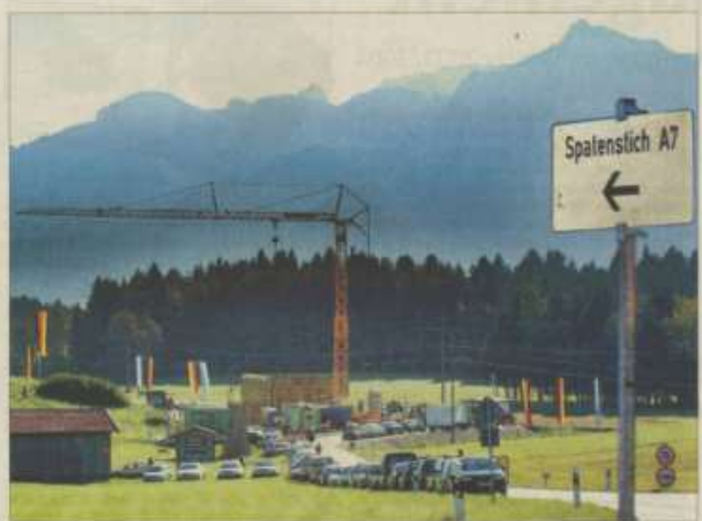
Mit dem Spatenstich begann gestern nahe Füssen offiziell der Bau für den Lückenschluss der Autobahn A7 zwischen Nesselwang und Füssen. Foto: Jörg Schollenbruch
