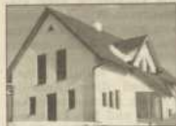
Hinter dieser Fassade verbirgt sich ein Holzhaus von Ligno-Trend
