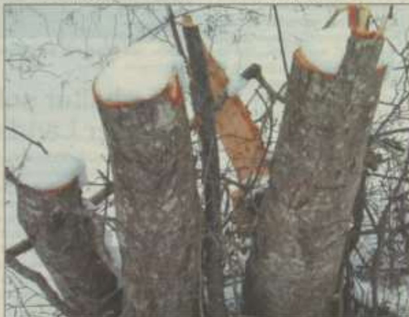
Vils - auf Stock gesetzte Grauerlen, die wieder in die neue Ufersicherung integriert werden.
