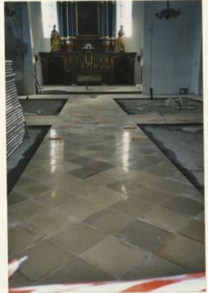
27.10.2002 Der Plattenboden ist fertig
