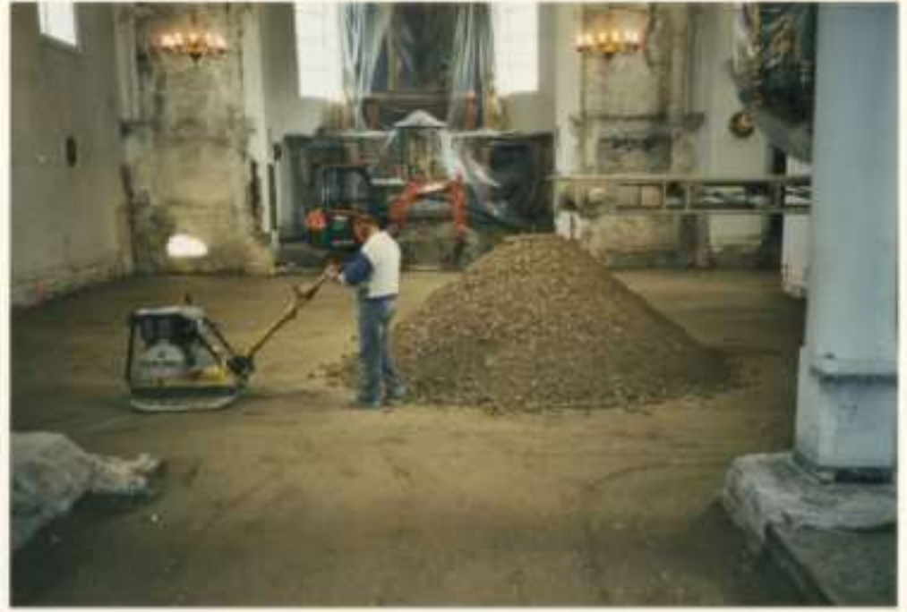
12. und 14. August 2002 Der Boden wird zugeschüttet. Eine 20 cm dicke EINKORN-(Filterkies) Betonschicht wird aufgetragen
