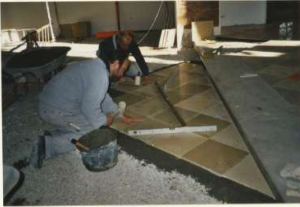
16.10.2002 Verlegen der Platten
