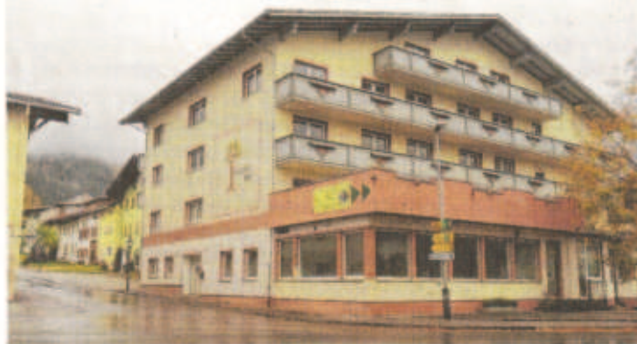
Der Grüne Baum in Vils steht seit Jahren leer. Jetzt soll das Haus abgerissen und durch einen kleineren Neubau ersetzt werden. Foto: Tschol
