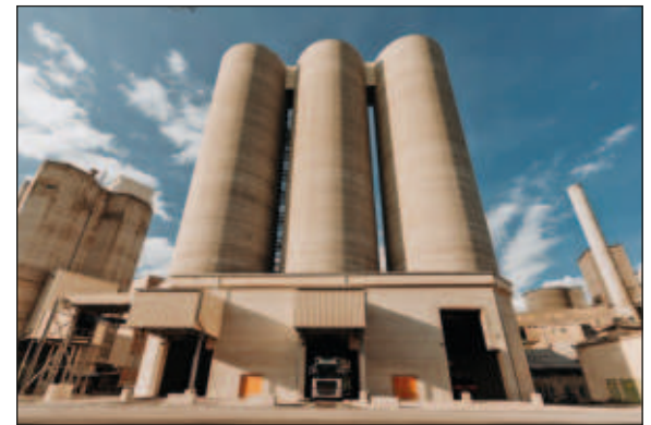
Frontansicht neue Siloverladeanlage
