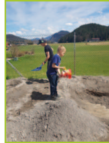
Die Bauarbeiten sind im vollen Gange!
