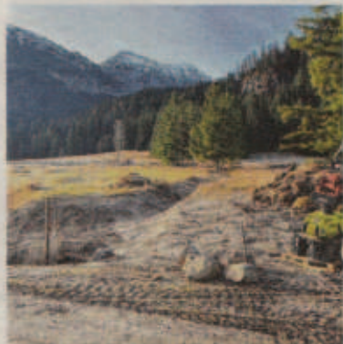
Hier wurde die neue Leitung Rich- tung Brunnenstube verlegt.
