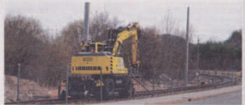
Keine Züge, sondern Spezialmaschinen, hier ein Bagger, fahren derzeit auf den Gleisen zwischen Vils und Reutte.
