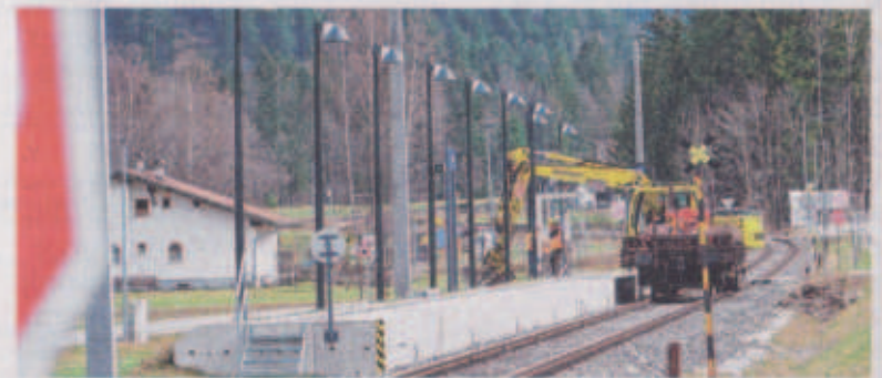
Die Bauarbeiten erstrecken sich auf einer Länge von knapp 15 km – hier die Haltestelle in Musau.
