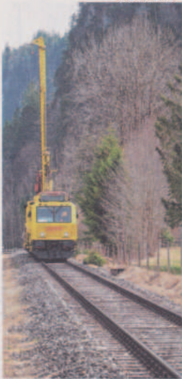
Schweres Gerät ist notwendig, um die Masten aufzustellen.
