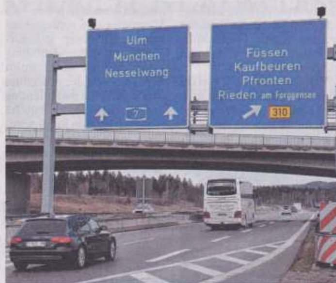
Der Verkehrsknoten A7/B310 wird adaptiert. Dafür muss die Autobahnabfahrt nach dem Grenztunnel ab 25. März geschlossen werden. Foto: Mittermayr
