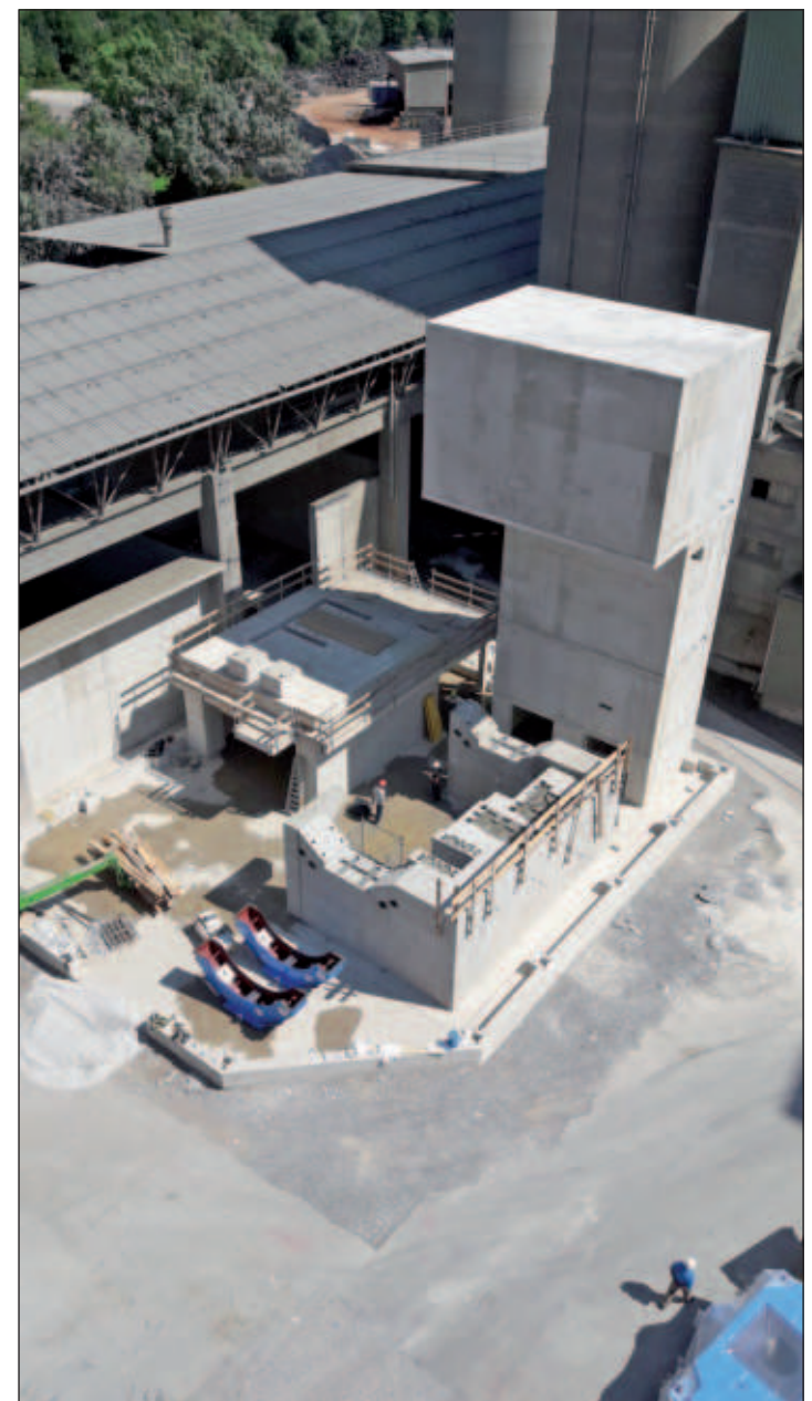
Fundamente und Elektorturm der neuen Zementmahanlage. Das Mühlengebäude wird in den nächsten Wochen fertiggestellt. (Foto: Schretter & Cie)
