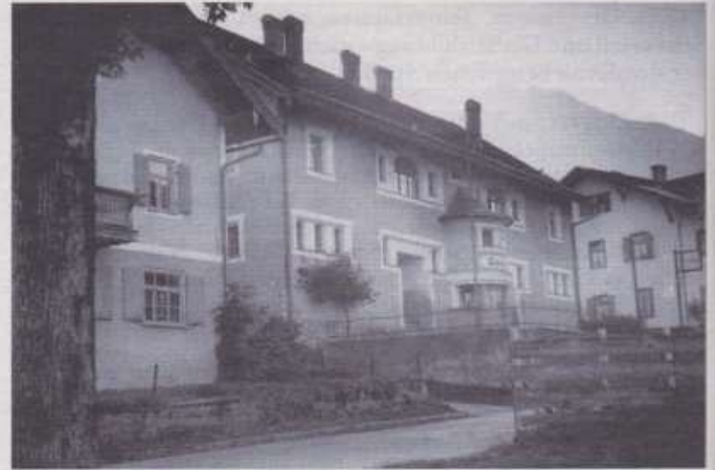
Das ehemalige Schulgebäude von Vils befindet sich heute in Privatbesitz. Als 1982 die neue Schule bezogen wurde, kaufte die Familie Natterer das ehemalige Schulgebäude, renovierte es und ließ es namentlich als „Alte Schule“ im Stadtbild weiterleben.
