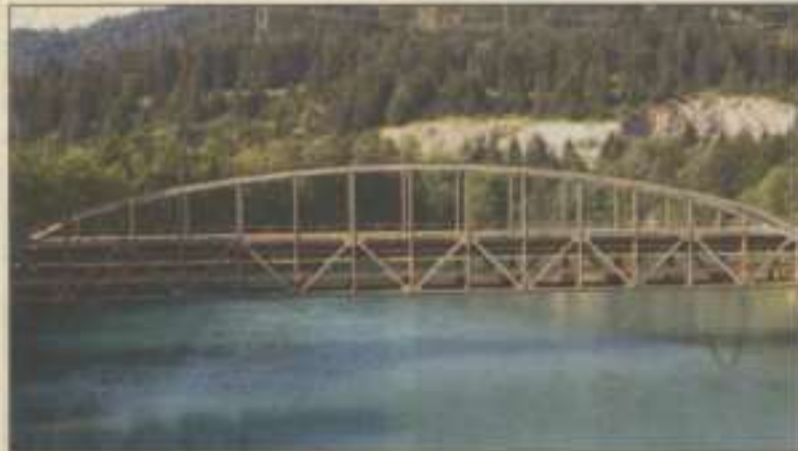
Die Lechbrücke wird ab diesem Wochenende saniert. Foto: Bahier
