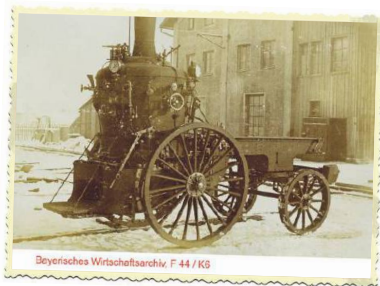
Ansicht einer Dampfspritze beim Aufbau in der Fa. Kraus & Comp.
