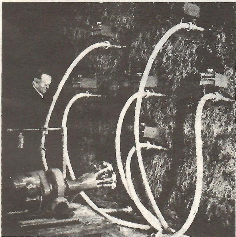
**DAS GEBLÄSEABKÜHLVERFAHREN** – patentrechtlich geschützt – wurde entwickelt, um die Temperatur in überhitzten Futterstößen zu senken, ohne die Stöße abzutragen.
