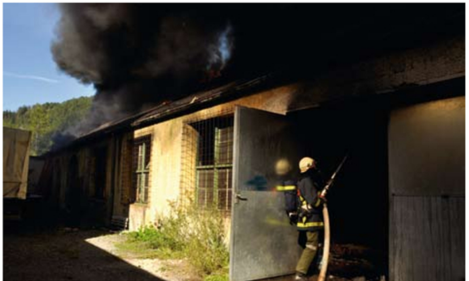
Enorme Rauchentwicklung – die leerstehende, große Lagerhalle stand im Vollbrand.
