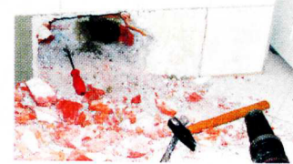
Der Kamin wurde von der FF Reutte aufgestemmt Fotos: FF Reutte
