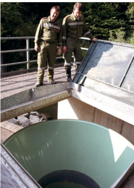
bern vom Dorfbach getrennt und dieser von einem Sammler auf maximal vier Meter (Dammkronenhöhe) mittels Pumpen angehoben und in den Inn gepumpt. Das Retentionsbecken wurde künstlich errichtet und wird vom Grundwasser des Inns gespeist. Pumpen mit einer Leistung von 21000 Liter/sek. regulieren im Einsatzfall den Wasserspiegel.
