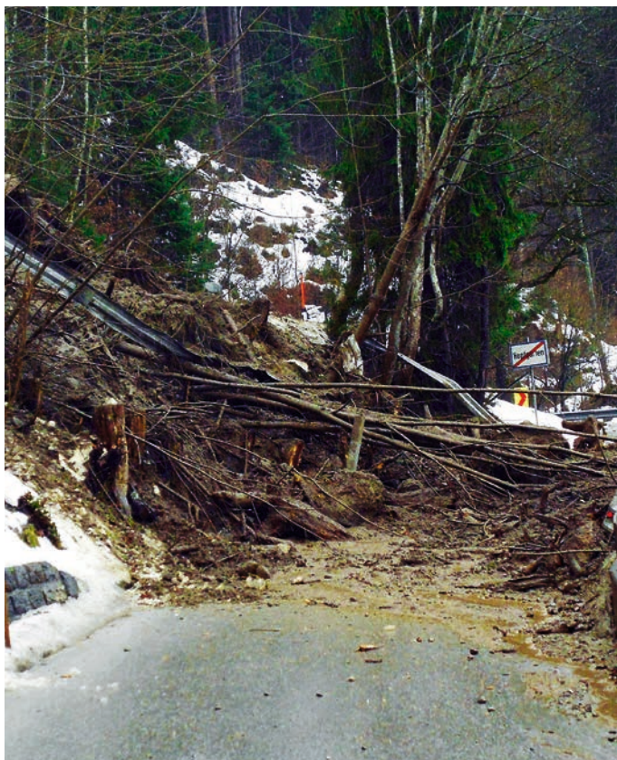
Im Bezirk Kitzbühel kam es zu Verlegungen von Straßen, so wie hier im Bild der Grafenberger Landesstraße.
