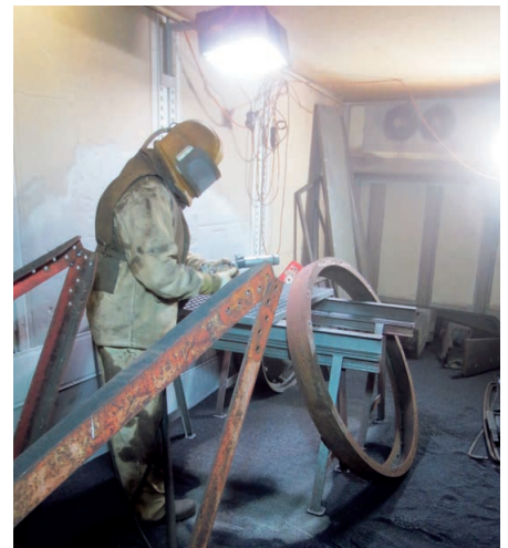
Knochenarbeit: Jedes einzelne Teil musste mit dem Sandstrahler gereinigt werden.
