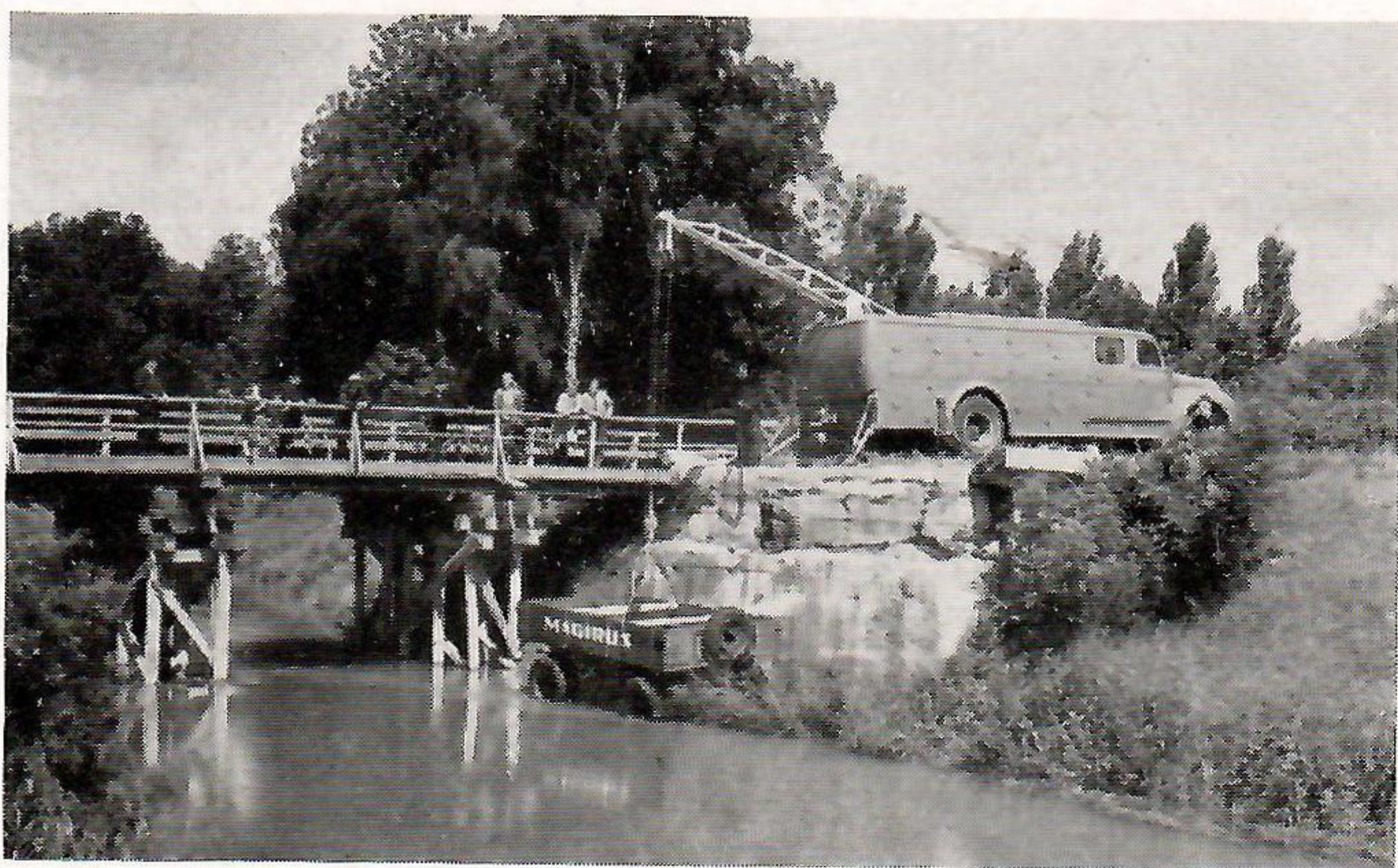
Bild 60 Rüstkraftwagen Baujahr 1950 beim Bergen eines Anhängers
