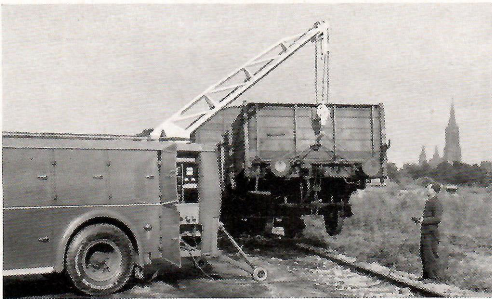
Bild 113 Einsetzen eines entgleisten Güterwagens
