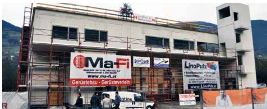
Das neue Feuerwehrhaus soll noch heuer fertiggestellt und im Frühjahr eingeweiht werden.
