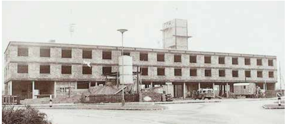
Der Rohbau der Hauptfeuerwache Innsbruck im Jahr 1965.
