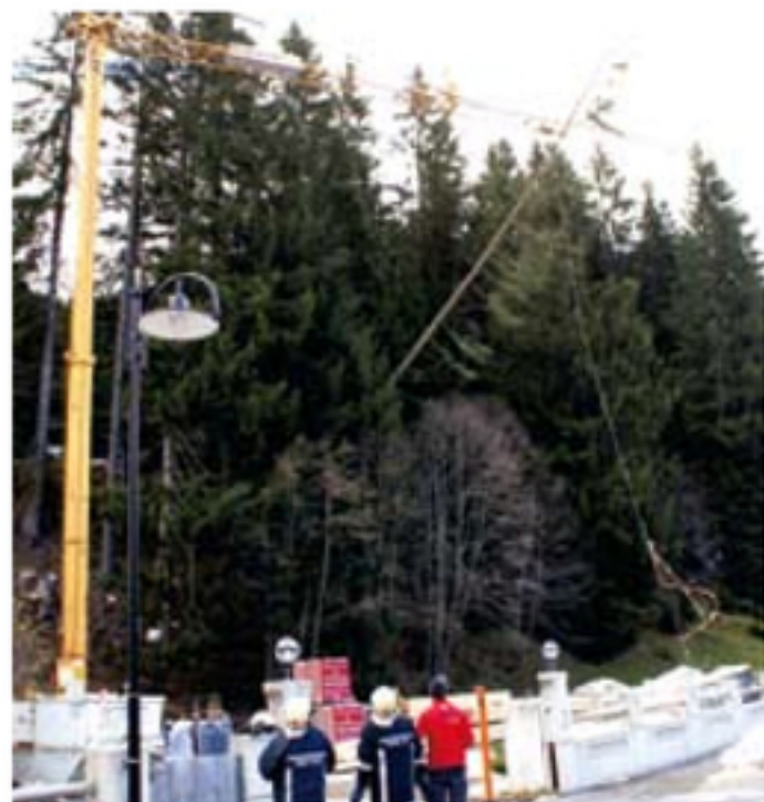
Der Baukran wurde vom Baum befreit!
