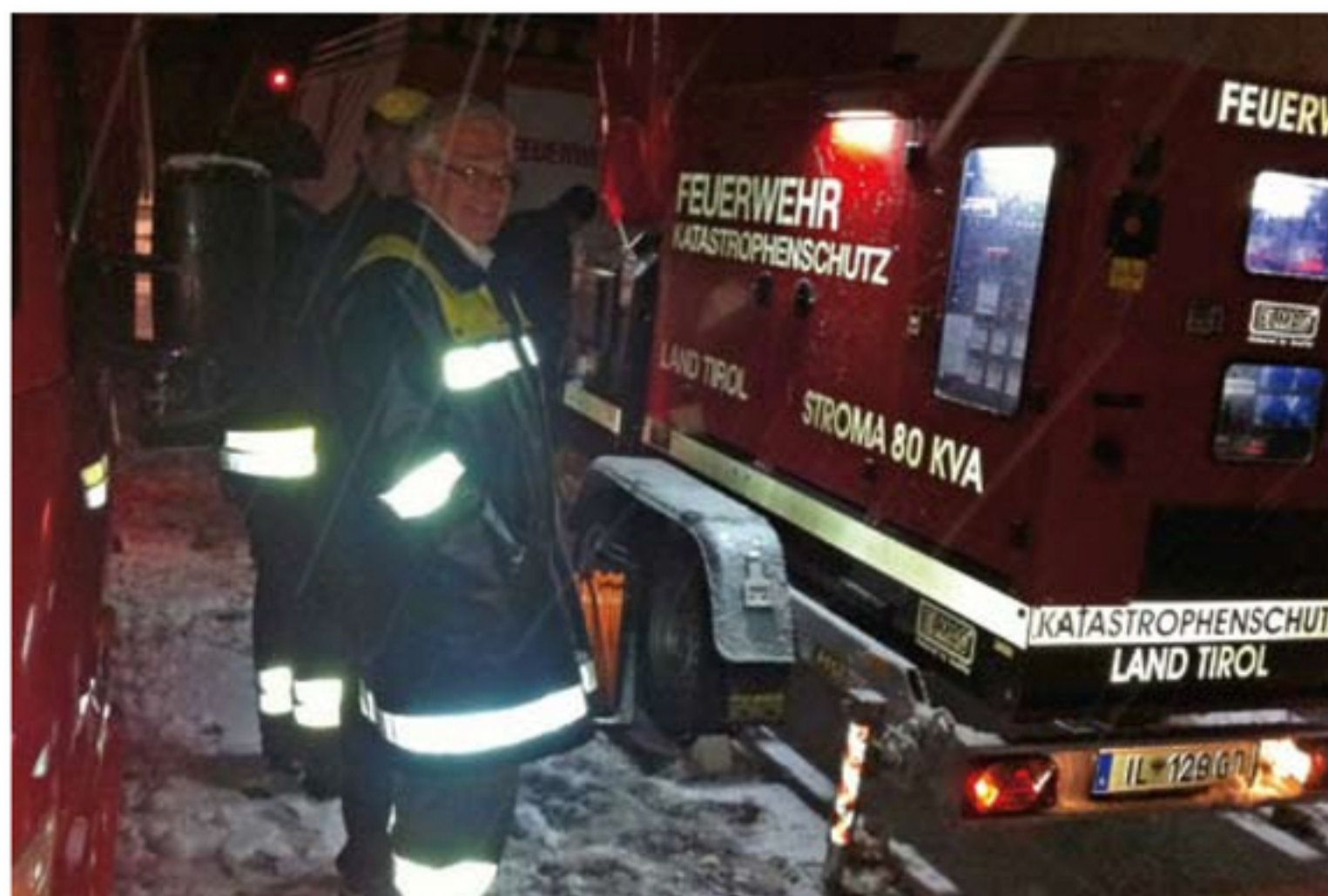
Das mobile Notstromaggregat überbrückte die Energieausfälle im Sellraintal!
