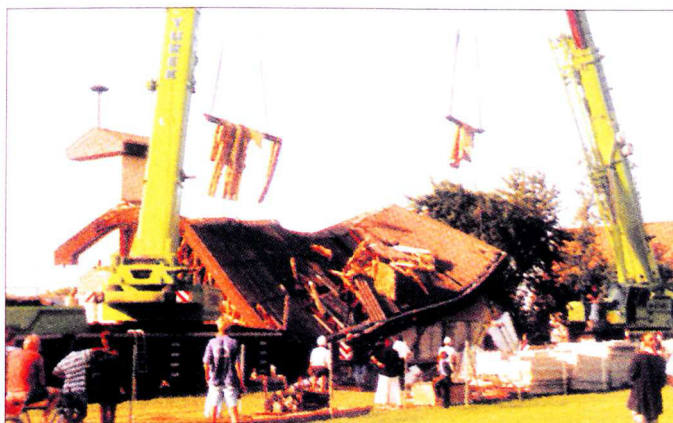
Grabungsarbeiten für den geplanten Zubau führten zum Einsturz des alten Rüsthauses. Foto. FF Unterpremstätten
