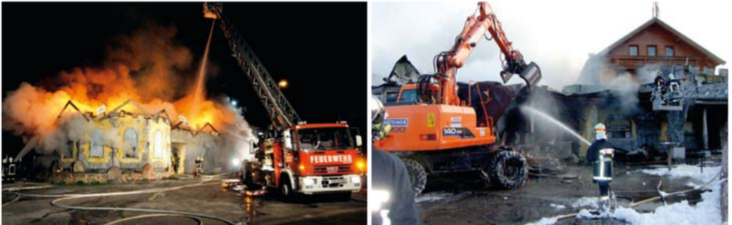
Um den Brand endgültig zu löschen, musste das Dach des Gebäudes mit schwerem technischen Gerät abgehoben werden (Bild rechts).
