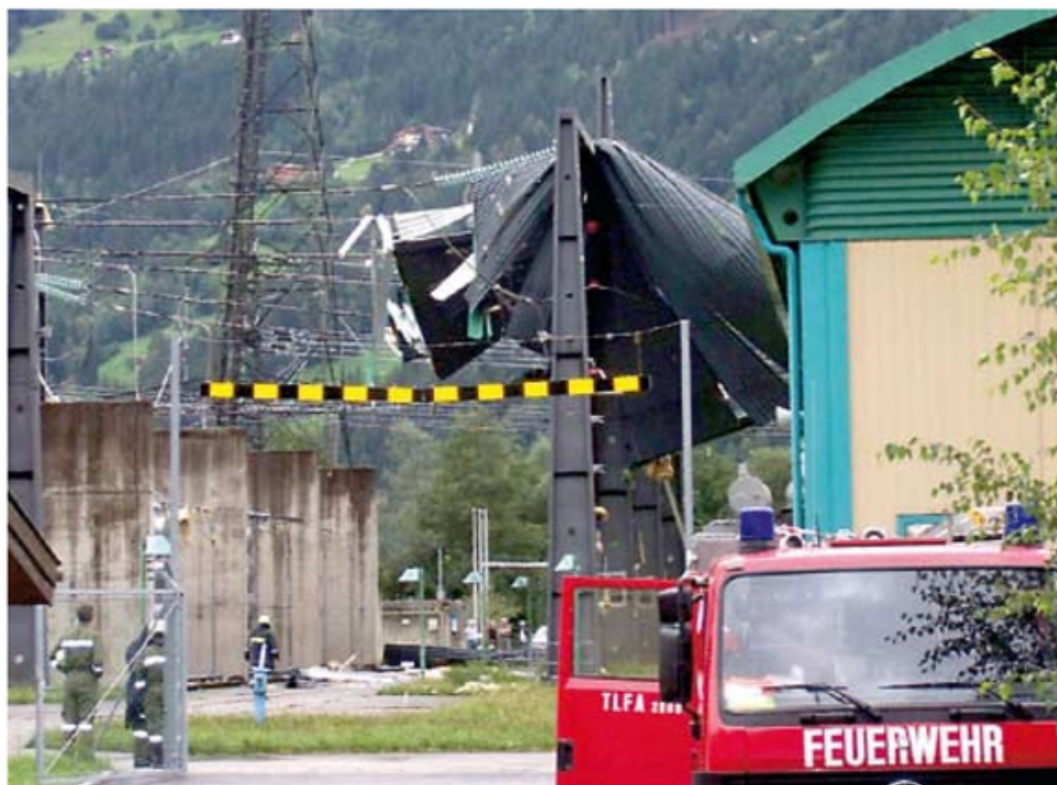
Orkanartige Windböen legten am 24. August 2010 die Stromversorgung in großen Bereichen des Zillertals lahm, nachdem eine Alu-Dachkonstruktion auf die 380-kv-Leitung stürzte.
