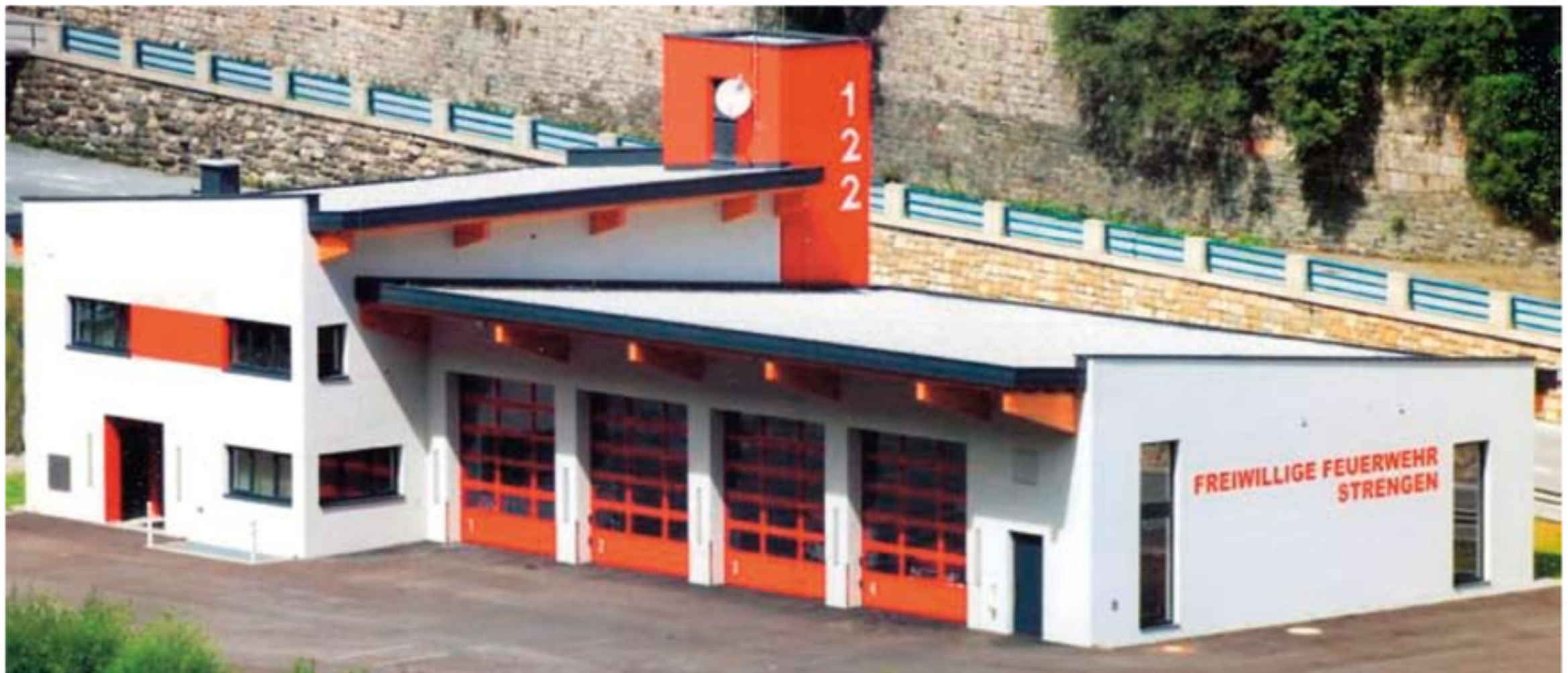
Das neue Gerätehaus Strengen, das vor kurzem eingeweiht wurde, präsentiert sich als funktionelles, zweckmäßiges Gebäude.
