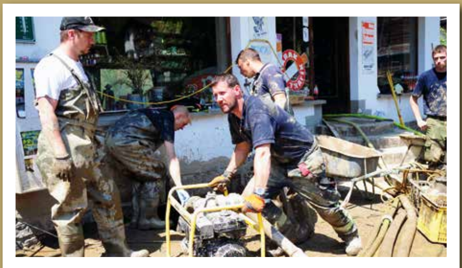
Am Tag danach schien wieder die Sonne – und das ganze Ausmaß der Verwüstungen wurde sichtbar! Die Devise war für alle Helfer klar: Hier muss angepackt werden.
