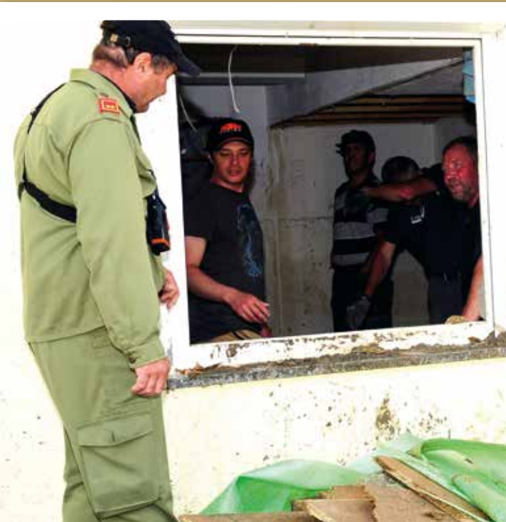
Wo Wasser, Schlamm und Dreck bis zur Decke reichen, ist der Einsatz aller verfügbaren Kräfte notwendig.
