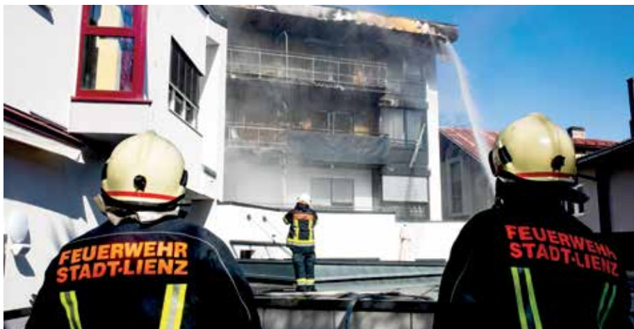
Der Brand im Wohntrakt griff in kurzer Zeit auf die Fassade und auf mehrere Balkone über.
