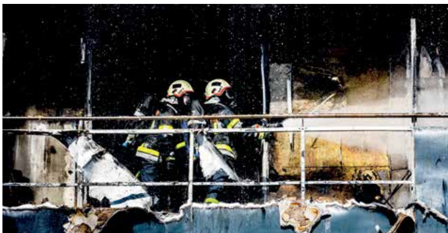
Der Brand wurde unter Kontrolle gebracht – der Sachschaden war allerdings enorm.
