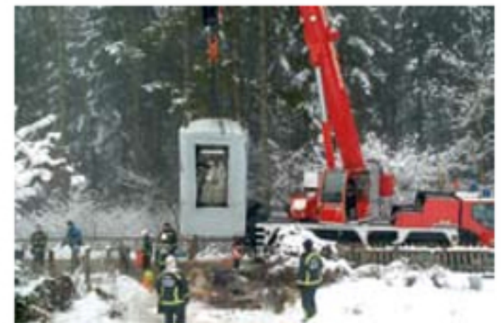
Schweres technisches Gerät war für die Bergung des Heizöltanks erforderlich.
