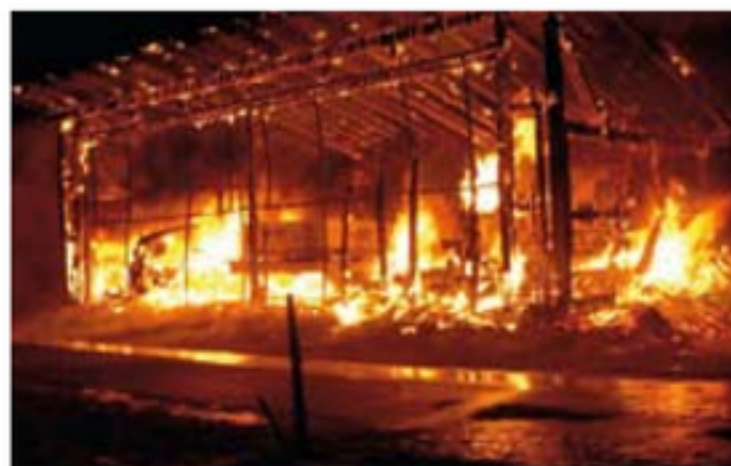
Diese Lagerhalle in Pfunds brannte vollständig nieder!
