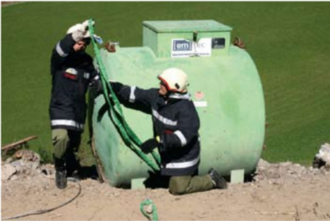
Wichtig: Sicherungsarbeiten an einem Dieseltank in Schwaz
