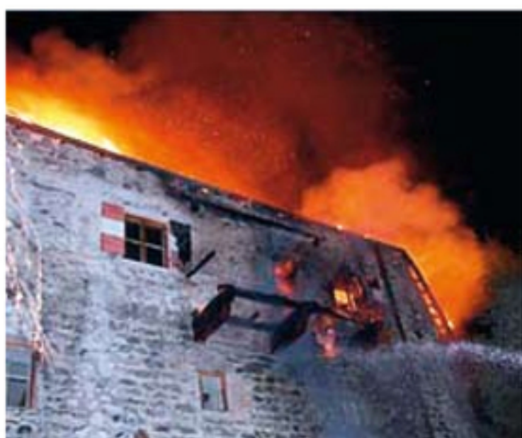
Das Dachgeschoss der 800 Jahre alten Burg Klamm in Obsteig stand in Flammen!
