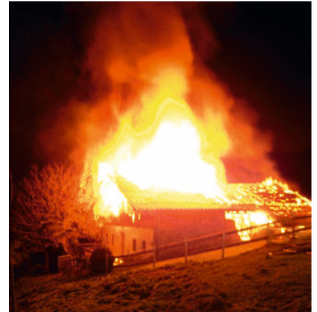
Beim Eintreffen der Einsatzkräfte stand die Hütte lichterloh in Flammen.
