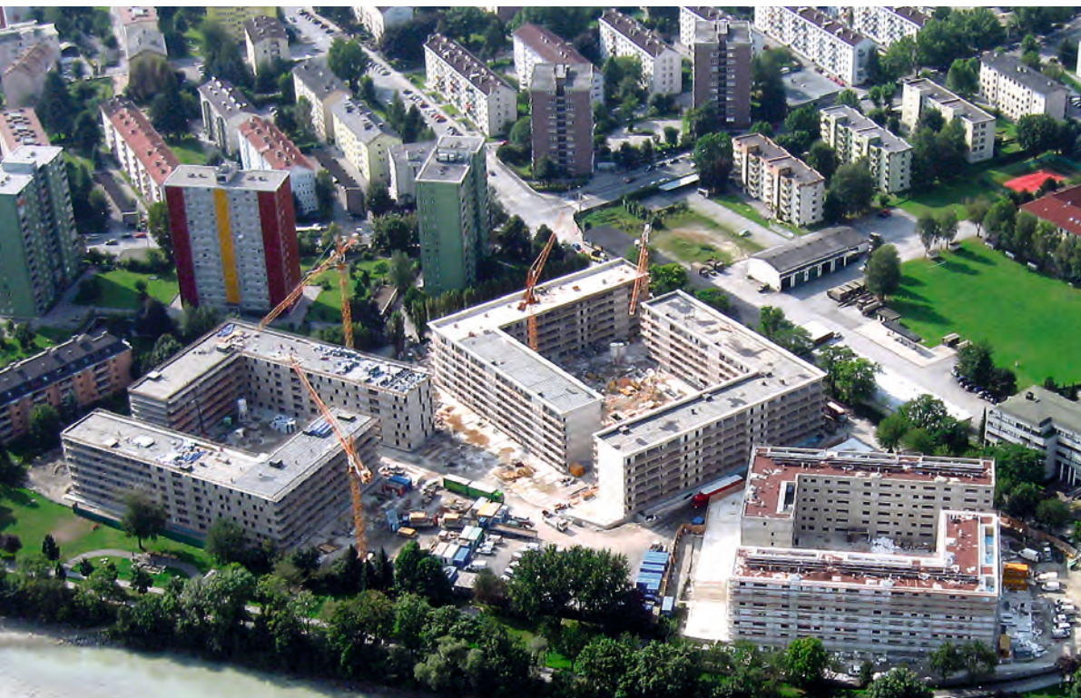
Wegweisend: Das Bauprojekt am Lodenareal entspricht auch brandschutztechnisch den modernsten Anforderungen.
